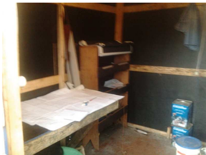
Figura 7 - Instalações Provisórias - Escritório
