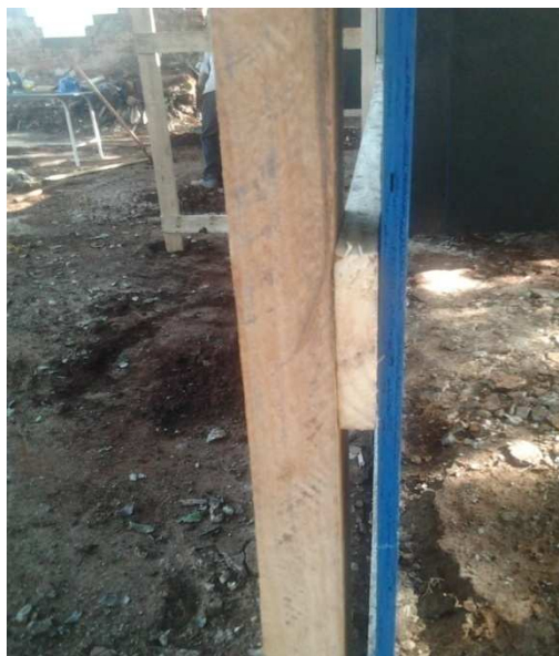
Figura 5 - Fixação de tapumes.
