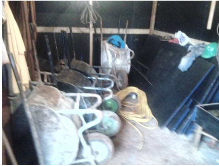
Figura 8 - Instalações Provisórias - Almoxarifado
