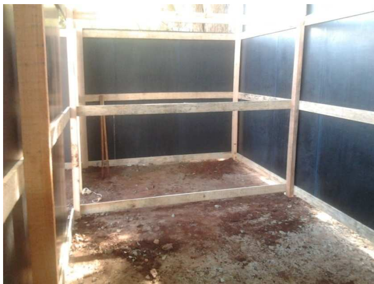
Figura 4 - Instalações Provisórias – Montagem.
