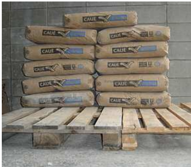
Figura 12 - Estrados sob as pilhas de cimento.
