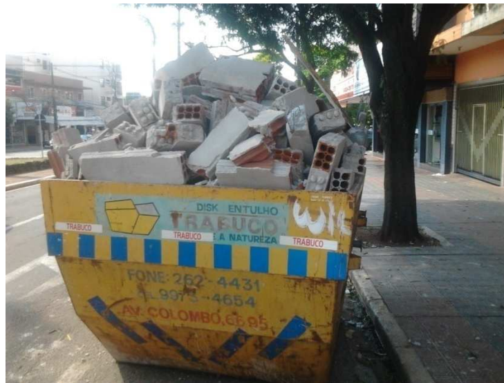
Figura 13 - Caçamba para descarte de entulho.
