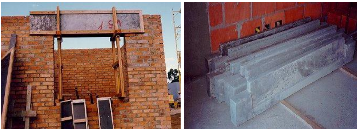
Figura 7 - Minimização no número de passos na execução de alvenaria
