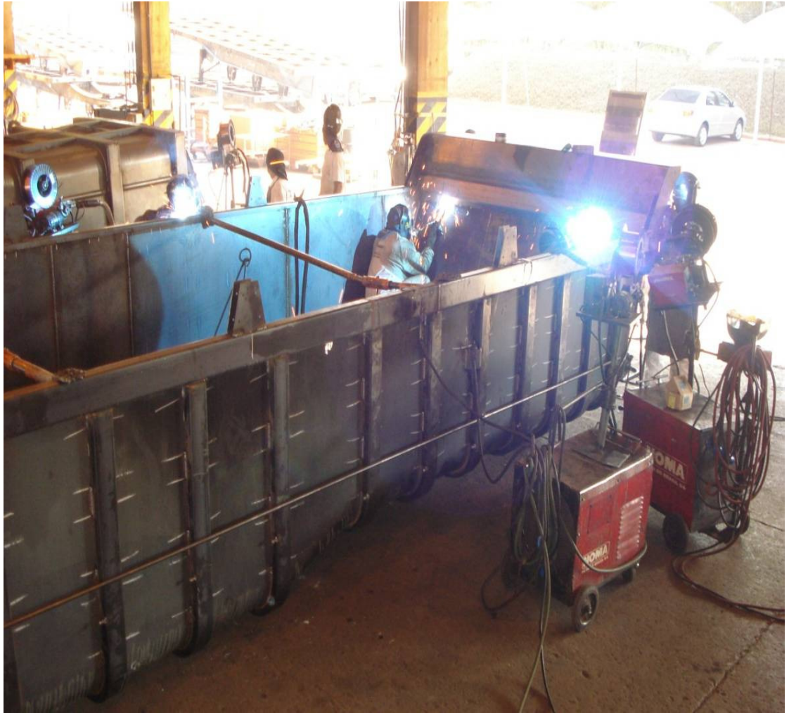
Figura 29: Foto soldagem caixa no chão
