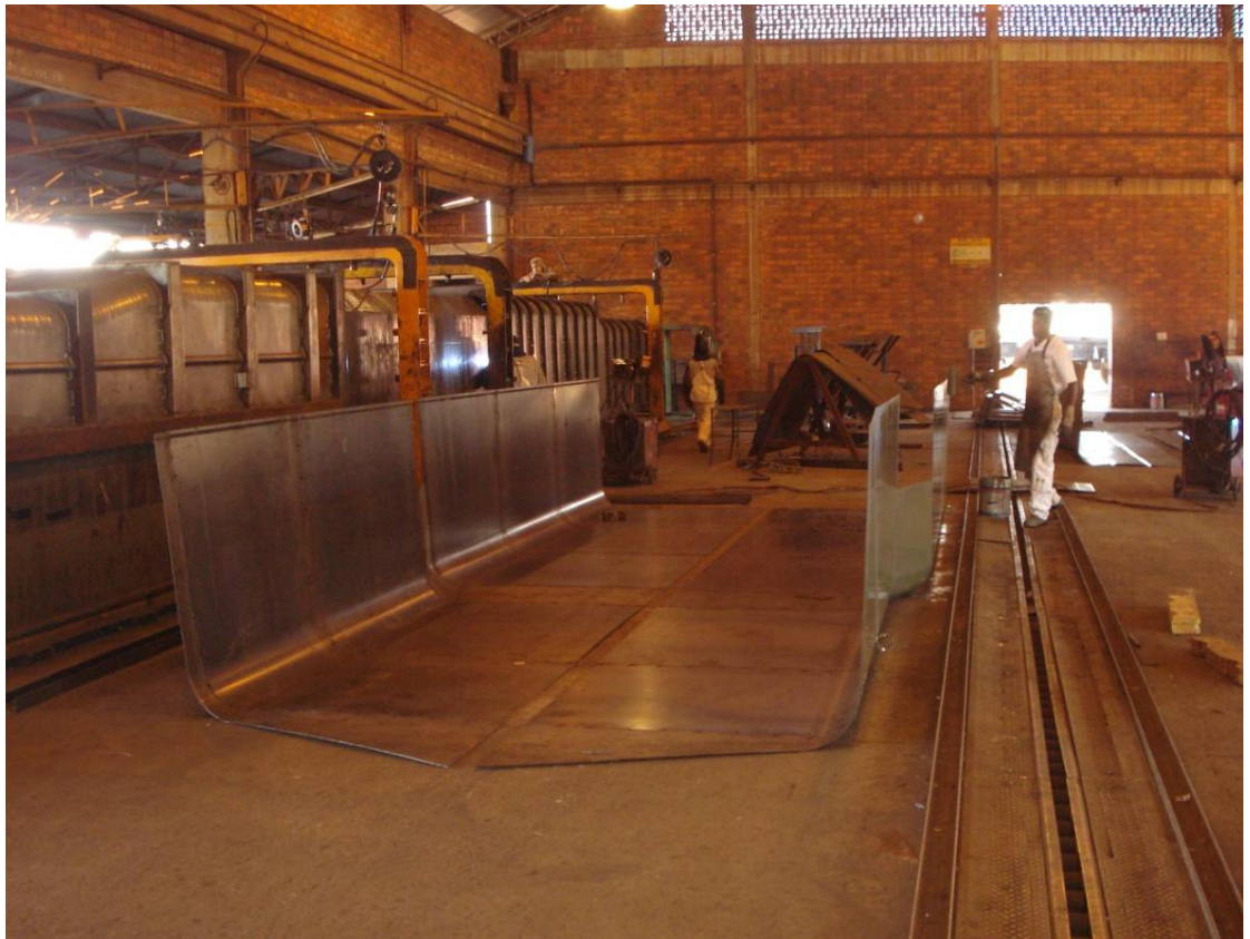
Figura 26: Montagem do corpo do implemento Semi - reboque basculante 25 m 3 .
