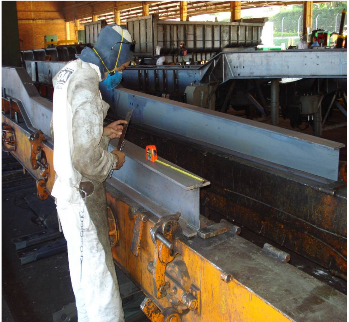
Figura 28: Foto da montagem do chassi do Implemento SRAB Dianteiro
