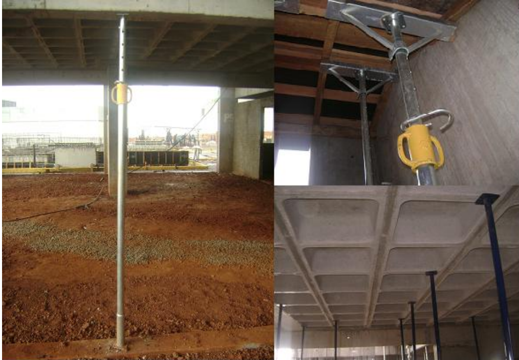
Figura 8: Escoras metálicas Fonte: Catamarã Engenharia, 2011.
