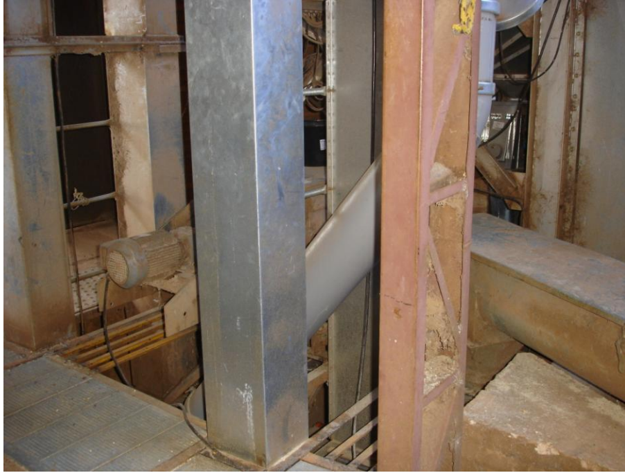
Figura 12: Poço do elevador
