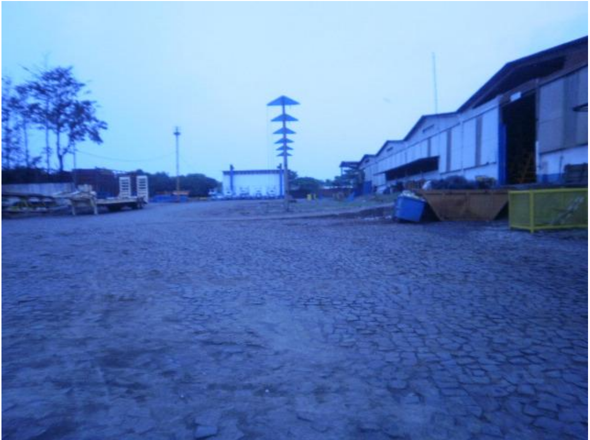
Figura 11 – Área sem cobertura, na qual foram retiradas as peças que estavam deteriorando
