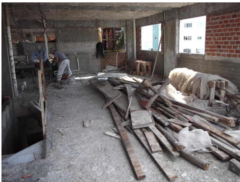
Figura 5: Transporte de materiais Canteiro A.
