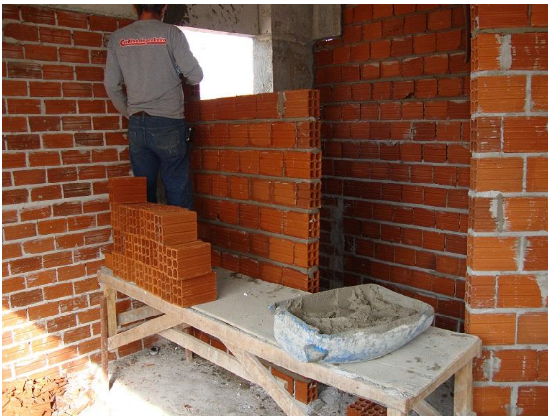
Figura 6: Execução de alvenaria no Canteiro B.
