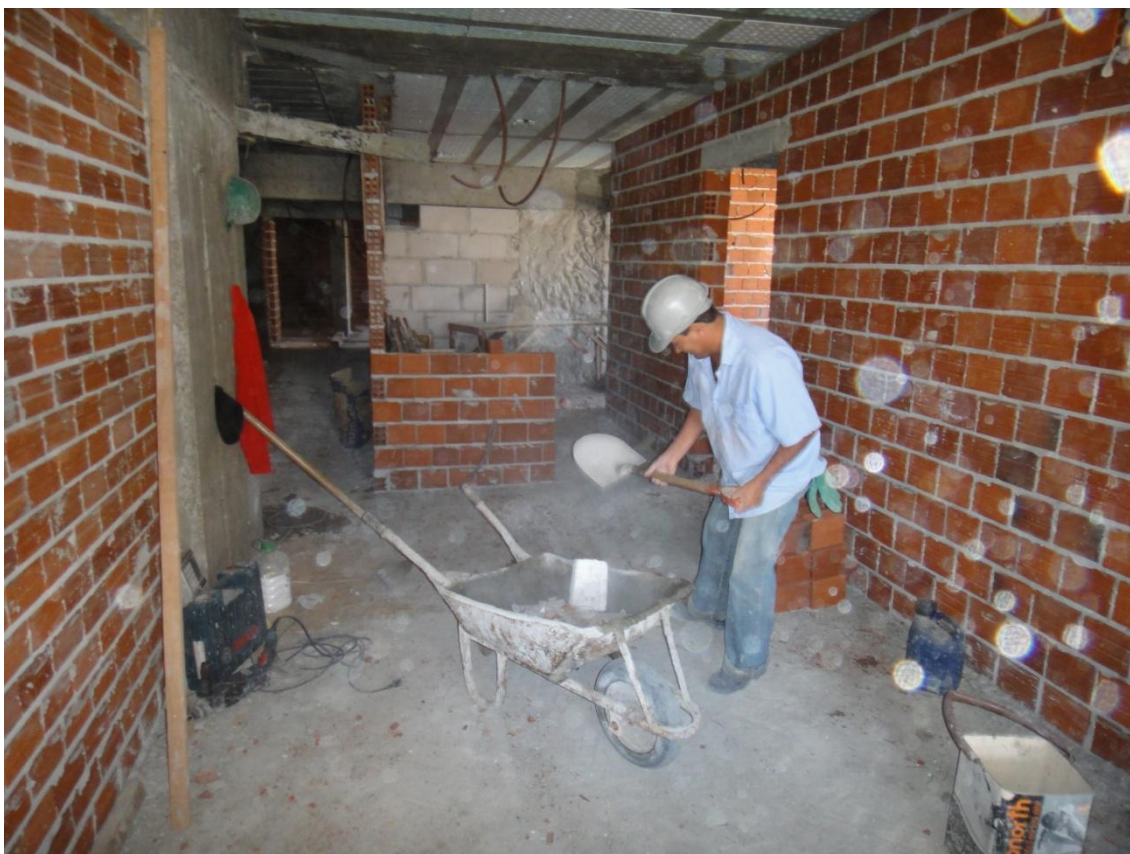
Figura 7: Realização de limpeza no Canteiro B.
