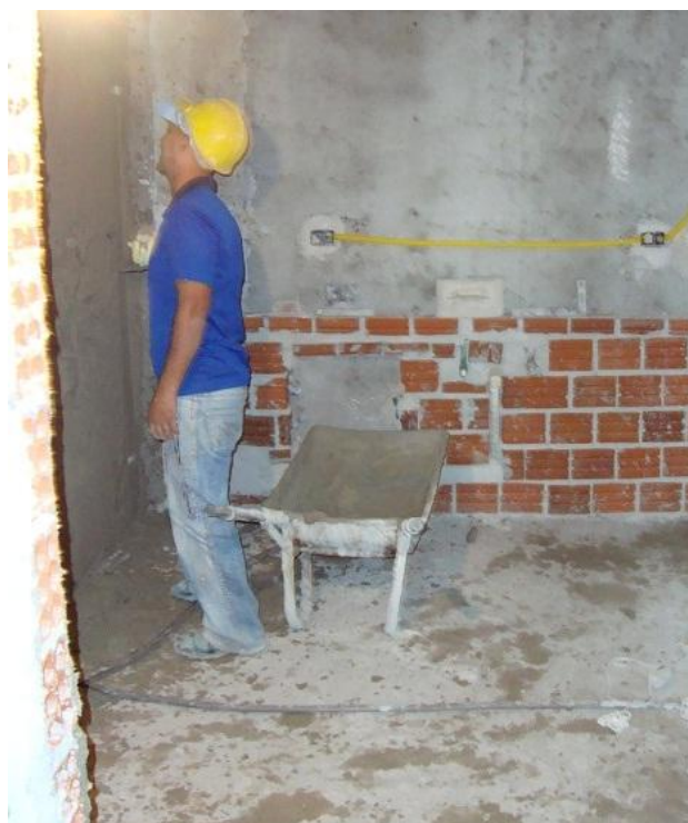
Figura 3: Execução de reboco no Canteiro A.
