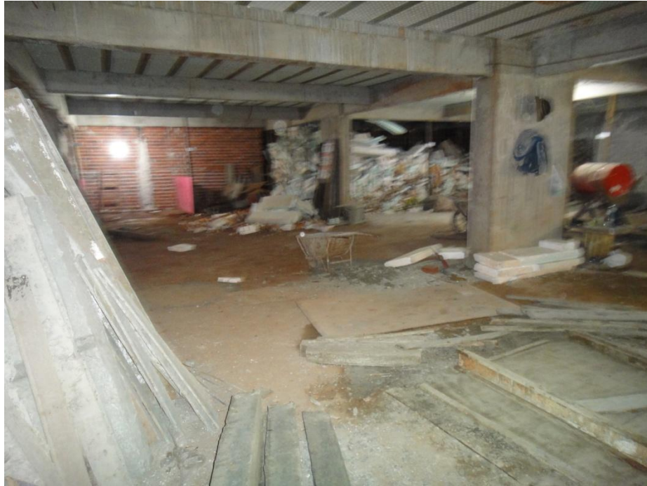
Figura 8: Subsola 2 do Canteiro B.
