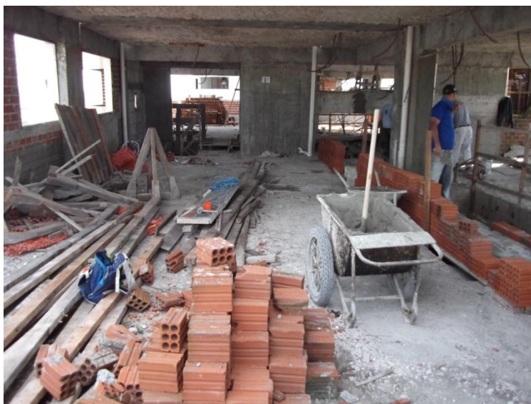
Figura 4: Execução de alvenaria no Canteiro A.
