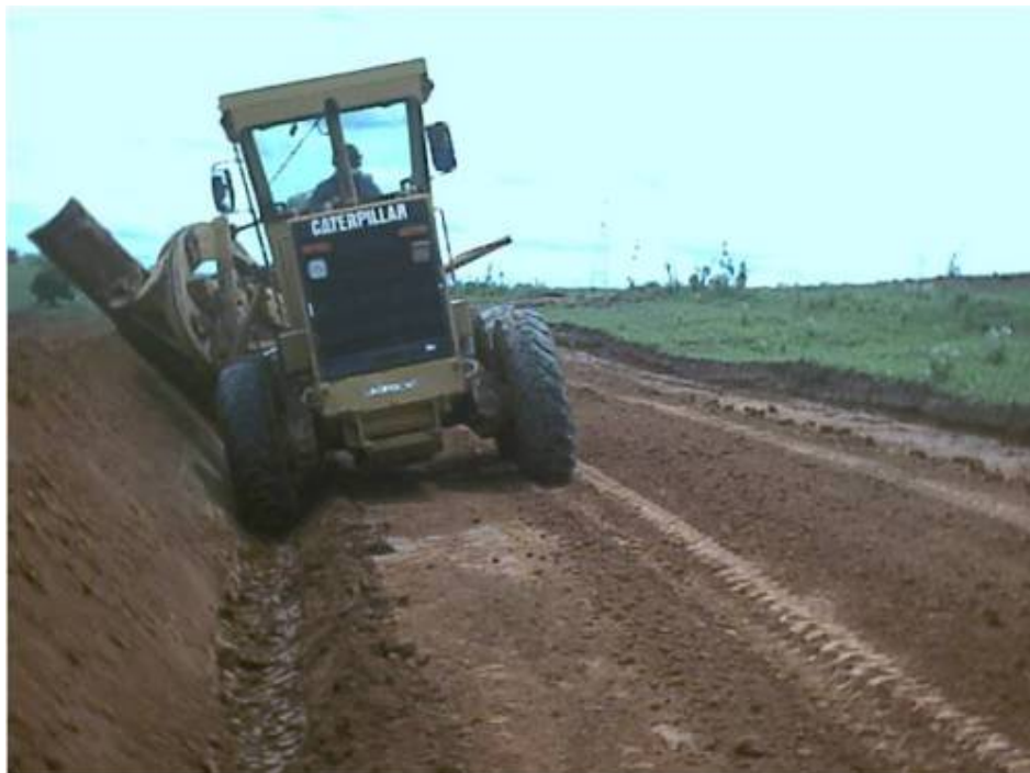
Figura 5: Construção de terraços e carreadores.
