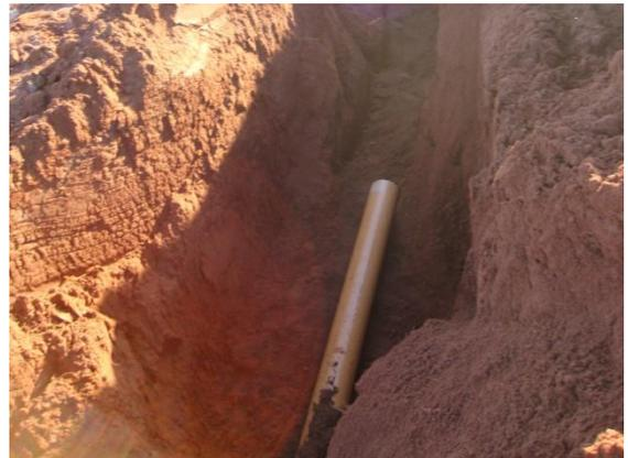
**Figura 10 - Rede de esgoto**
