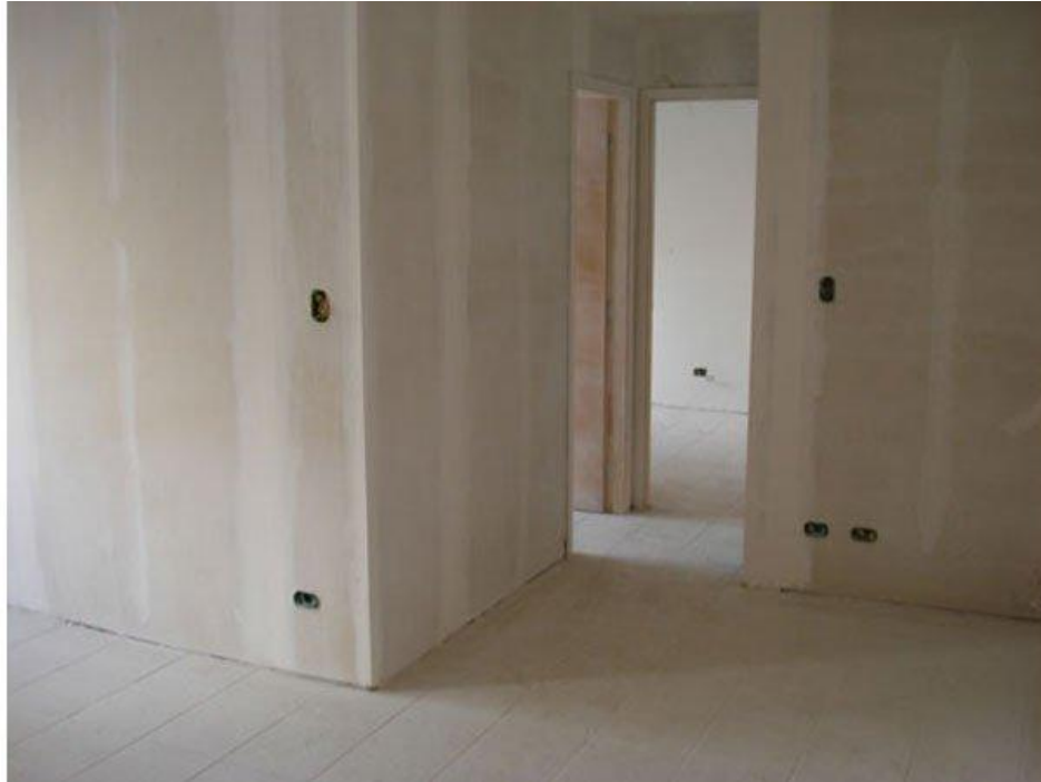
Figura 28: Parede de gesso acartonado pronta para revestimento (Obra: Edifício Saint Paul da cidade de Maringá-PR)
