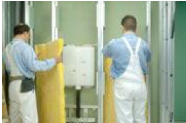
Figura 21: Colocação de isolamento térmico e acústico (Fonte: Nogueira et. al , 2004)
