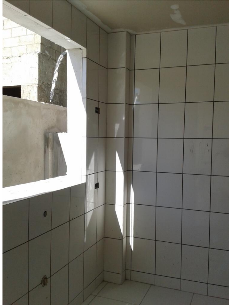
Figura 31: Utilização de placas cerâmicas sobre as chapas de gesso acartonado (Obra: Edifício Saint Paul da cidade de Maringá-PR)
