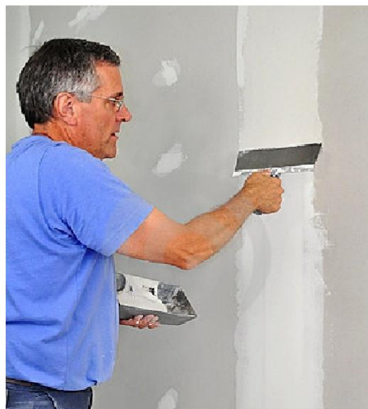
Figura 25: Tratamento das juntas em suas diferentes etapas (Fontes: Adaptado: www.knauf.com.br ; www.trevobrasil.com.br )
