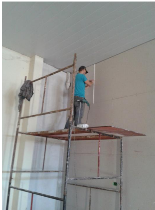
Figura 17: Parafusamento das chapas da primeira face (Obra: Galpão Municipal de Maringá-PR)
