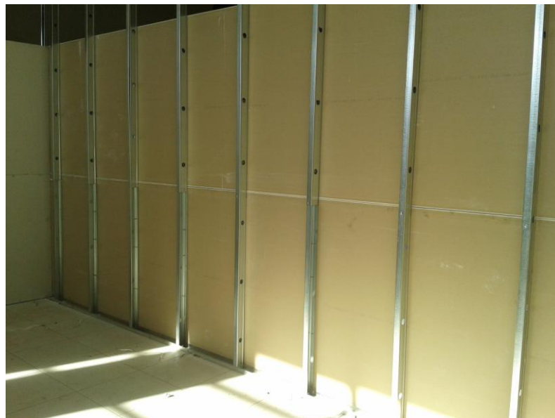
Figura 19: Primeira face da divisória montada (Obra: Galpão Municipal de Maringá-PR)
