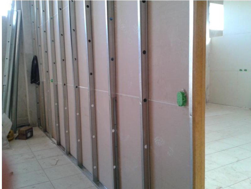
Figura 18: Primeira face da divisória montada (Obra: Galpão Municipal de Maringá-PR)
