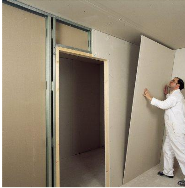
Figura 23: Fechamento da segunda face da divisória
