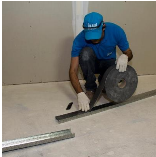
Figura 15: Colocação de fita elástica auto-adesiva
