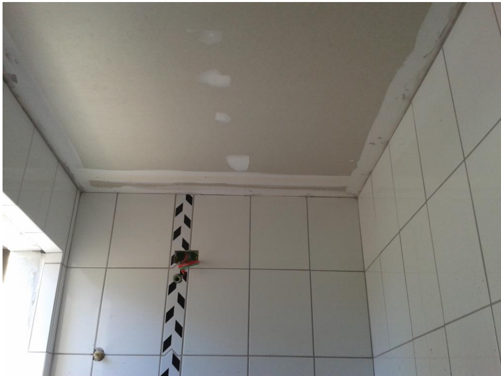
Figura 30: Utilização de placas cerâmicas sobre as chapas de gesso acartonado (Obra: Edifício Saint Paul da cidade de Maringá-PR)
