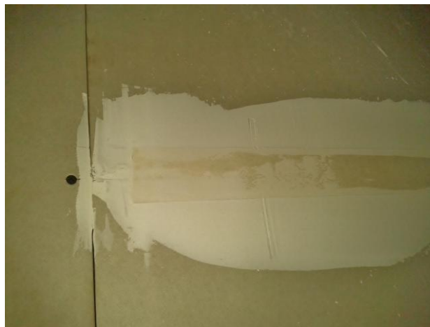
Figura 27: Massa aplicada para o recobrimento de fitas (Obra: Galpão Municipal de Maringá-PR)
