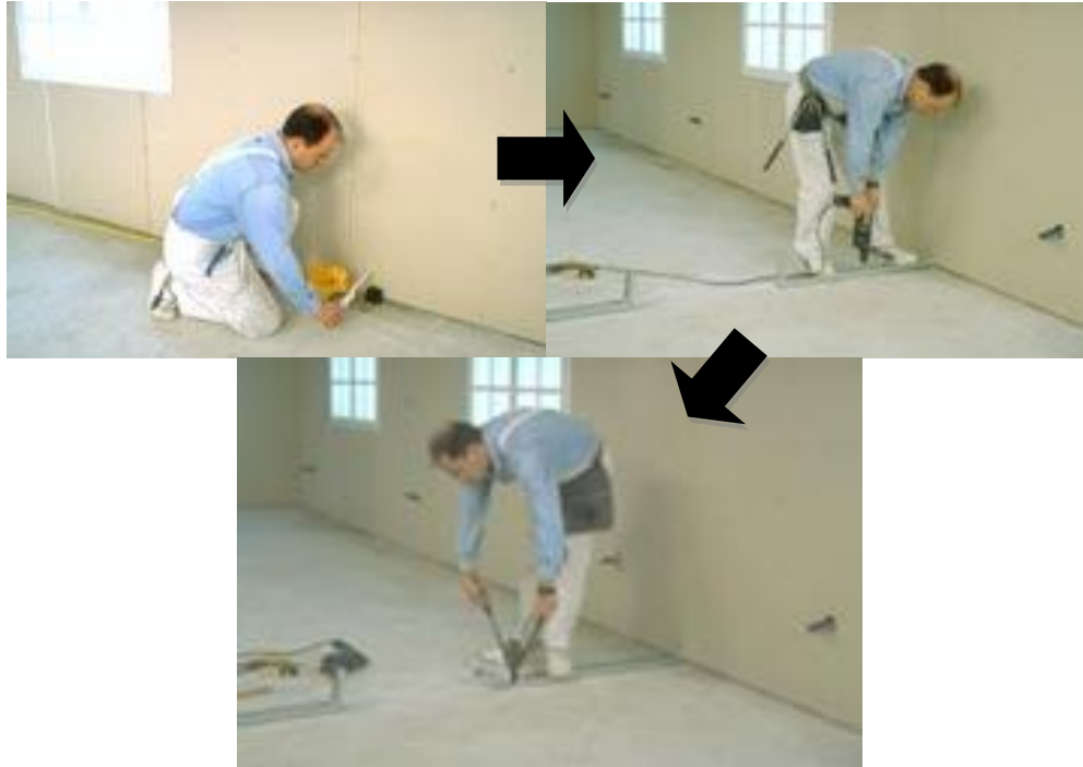
Figura 14: Locação e fixação das guias
