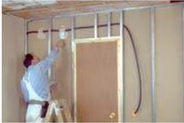
Figura 20: Colocação de passagem para tubulações (Fonte: Nogueira et. al , 2004)
