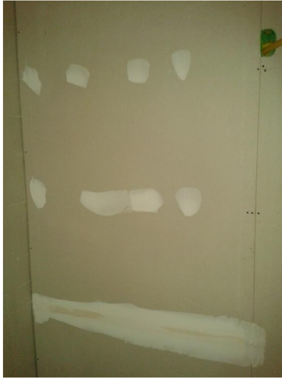
Figura 26: Massa aplicada para o recobrimento de fitas e cabeças dos parafusos (Obra: Galpão Municipal de Maringá-PR)
