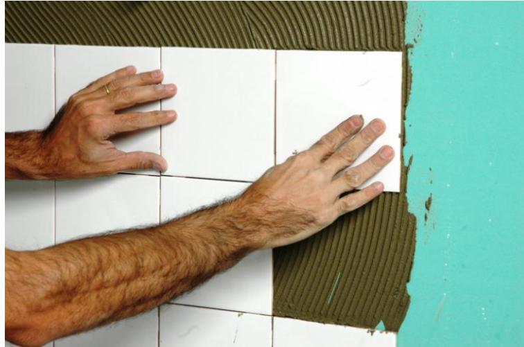
Figura 29: Aplicação de placa cerâmica sobre as placas de gesso (Fonte: www.knauf.com.br )
