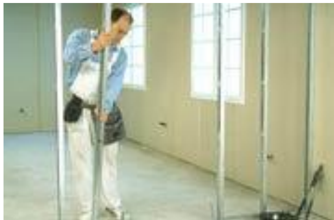
Figura 16: Colocação dos montantes
