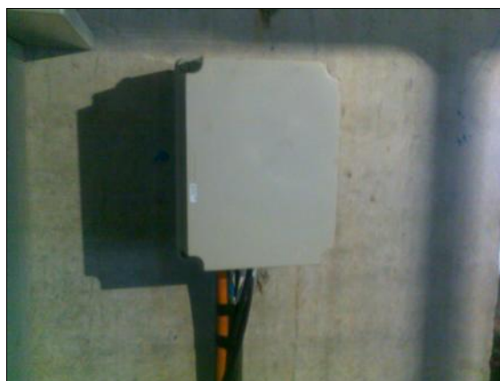
Figura 29 - Instalação Elétrica Reparada
