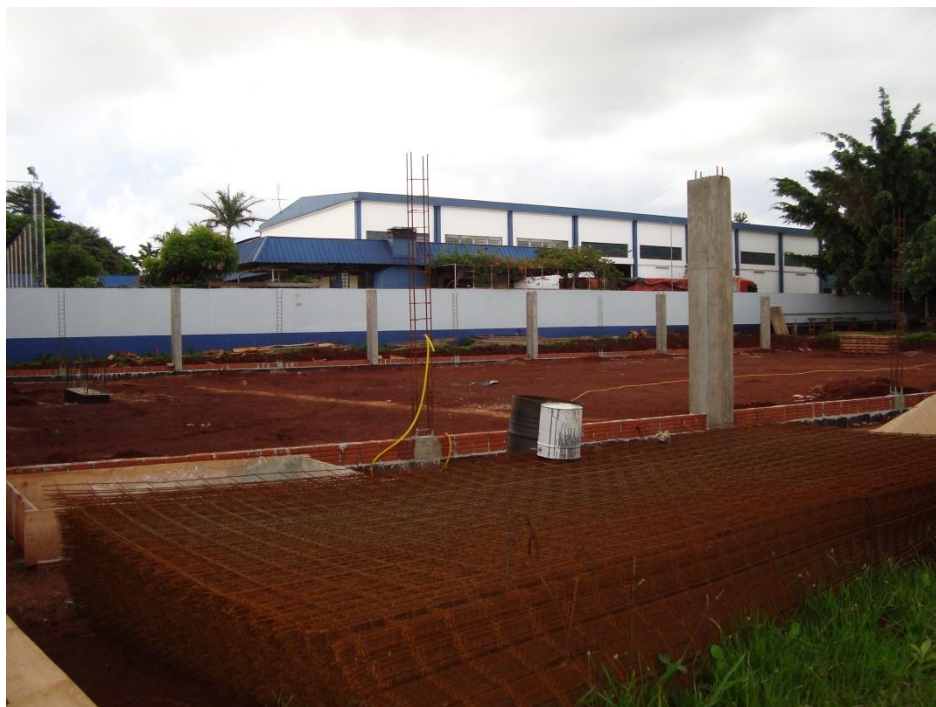
Figura 13 – Início das obras do barracão
