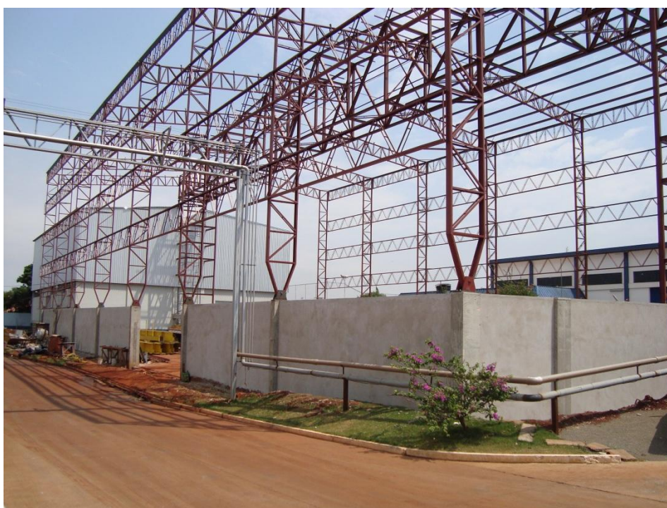
Figura 14 – Obras em andamento
