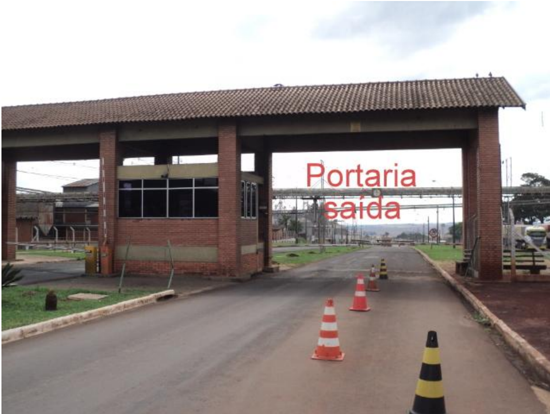
Figura 9: Portaria de Saída do Caminhão Carregado
