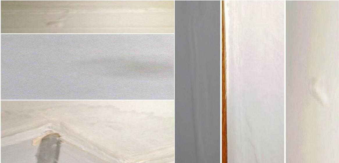
**Figura 23: Imperfeições na pintura e mancha e bolhas na pintura antes da melhoria**
