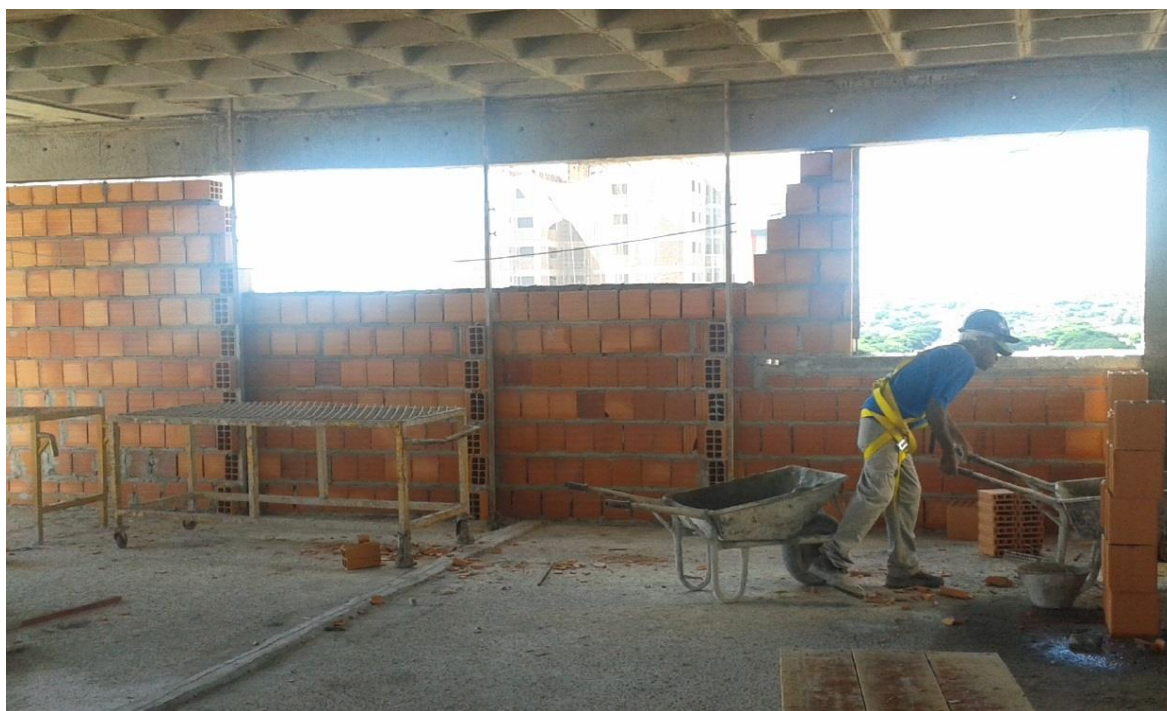
Figura 7: Uso de escantilhões para auxiliar a elevação da alvenaria.
