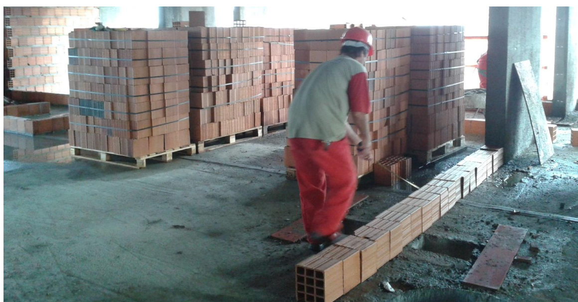
Figura 12: Atividade de marcação de alvenaria.
