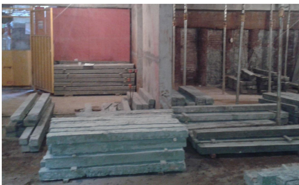
Figura 13: Simplificação através do uso de vergas pré-moldadas.
