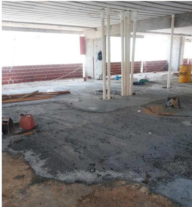
**Figura 4.4 – Preenchimento de concreto na laje para consertar irregularidades.**
