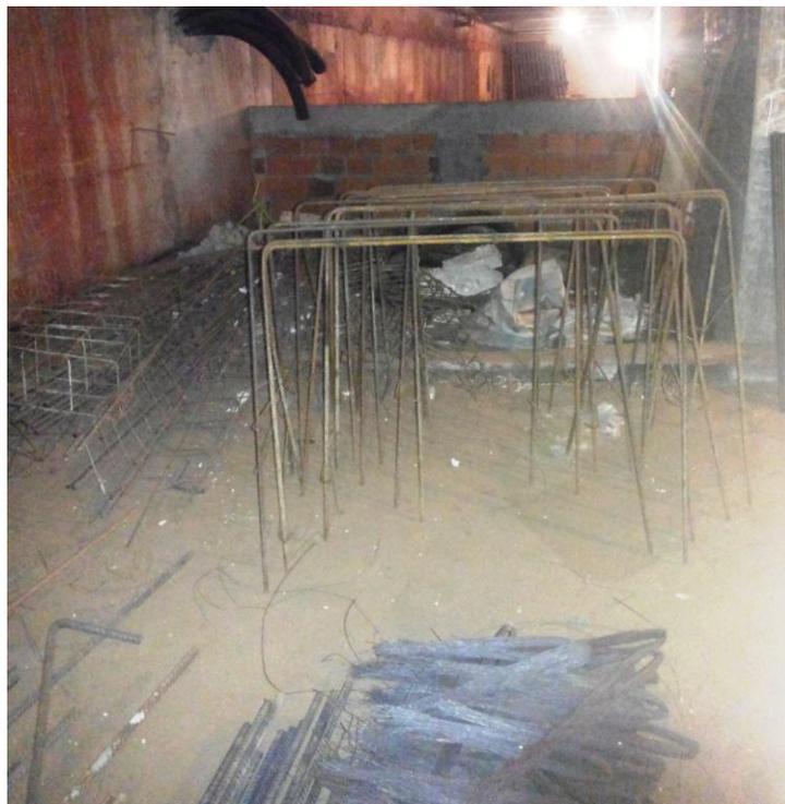
**Figura 4.7** – Armazenamento de material juntamente com resíduo.
