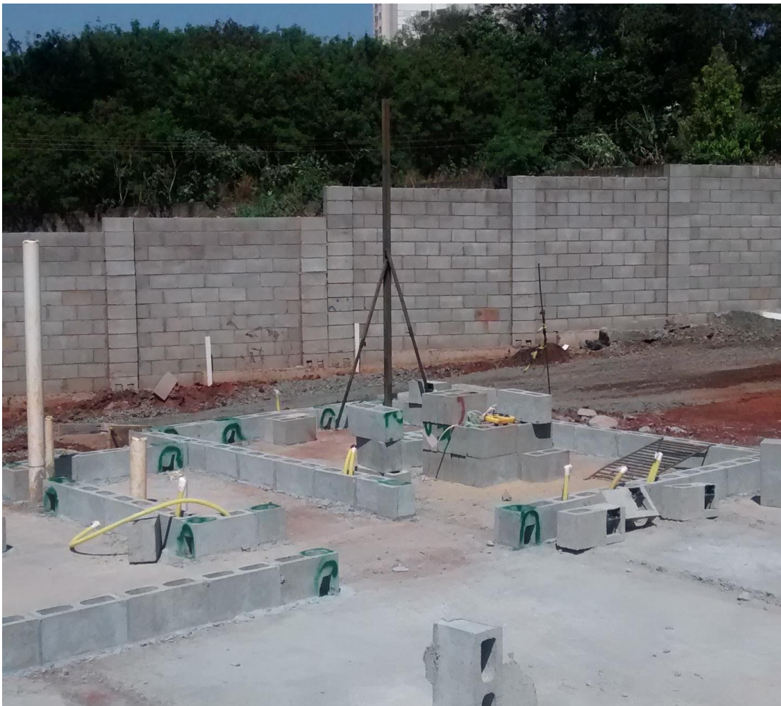
Figura 23: Foto da proposta de melhoria de utilização do escantilhão.
