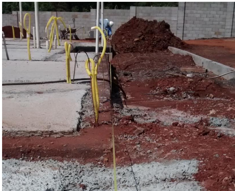
Figura 25: Foto da proposta de melhoria de marcação da alvenaria.
