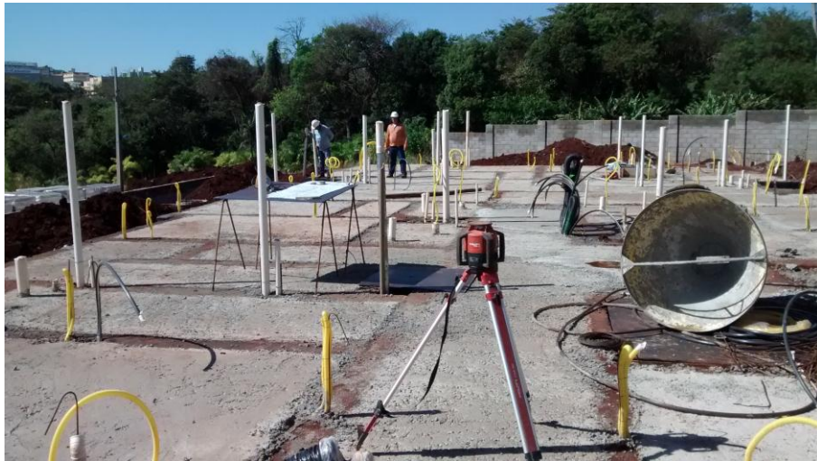
Figura 24: Foto da proposta de melhoria de utilização de nível laser.
