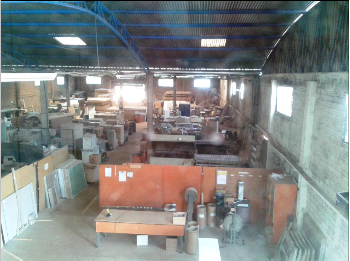
Figura 17 - Fotografia de vista geral.
