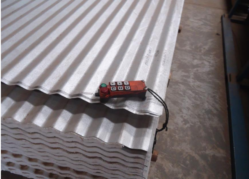
Figura 19: Controle da ponte deixado em qualquer lugar.
