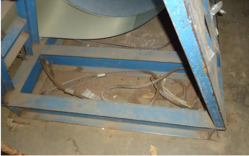
Figura 16: Cabo de aço guardado embaixo do cavalete.
