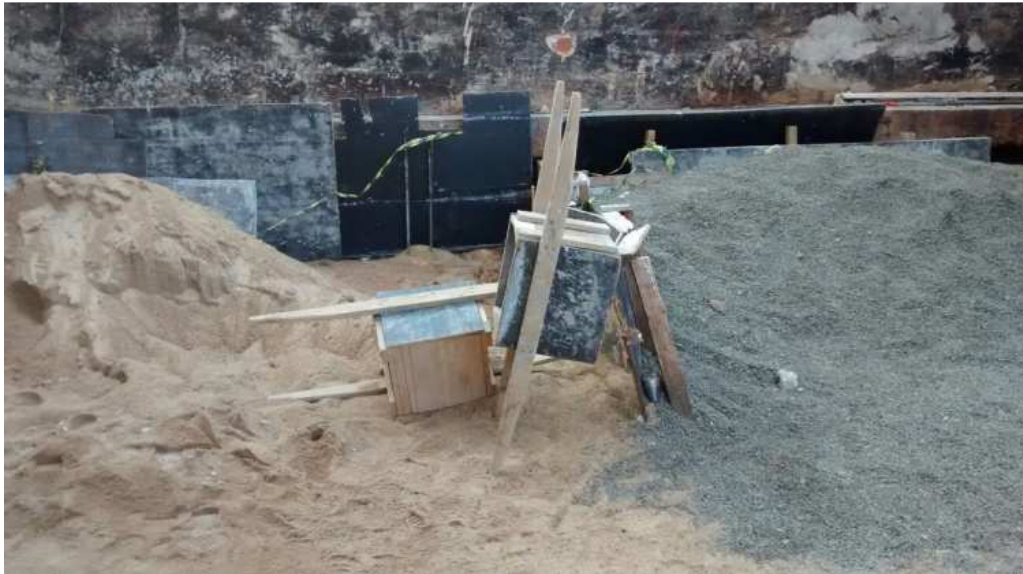
Figura 27- Lugar de armazenagem de areia e brita Fonte: Autor
