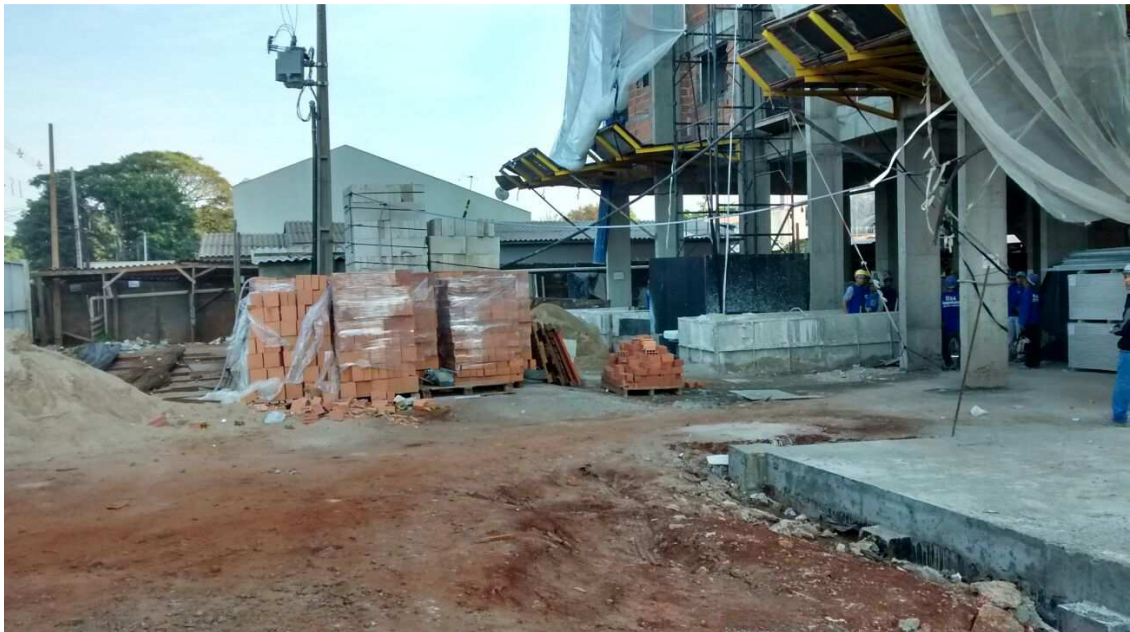
Figura 11-Desorganização e desperdício no canteiro de obra Fonte: Autor
