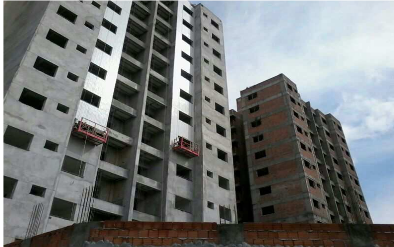
Figura 8-Fachada Edifício 01 em Construção Fonte: Autor
