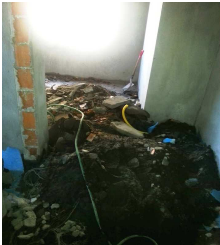
Figura 34- Desperdícios 01 na Obra Fonte: Autor
