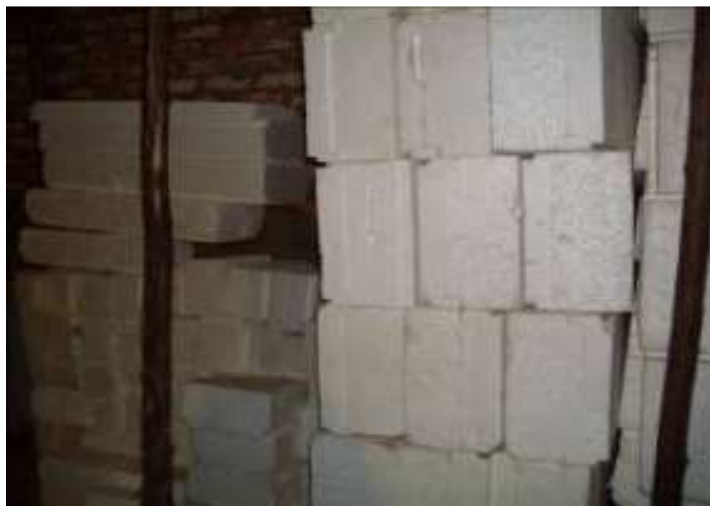
Figura 31- Reordenamento dos blocos de concreto Fonte: Pimentel (2009)
