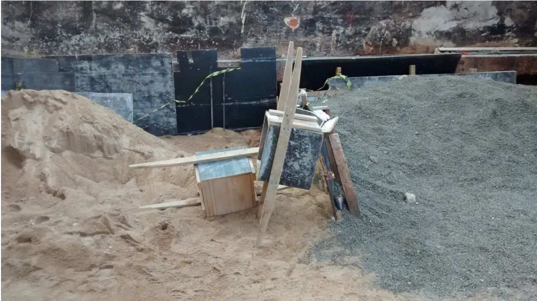
Figura 9-Local de armazenamento de areia e agregado Fonte: Autor
