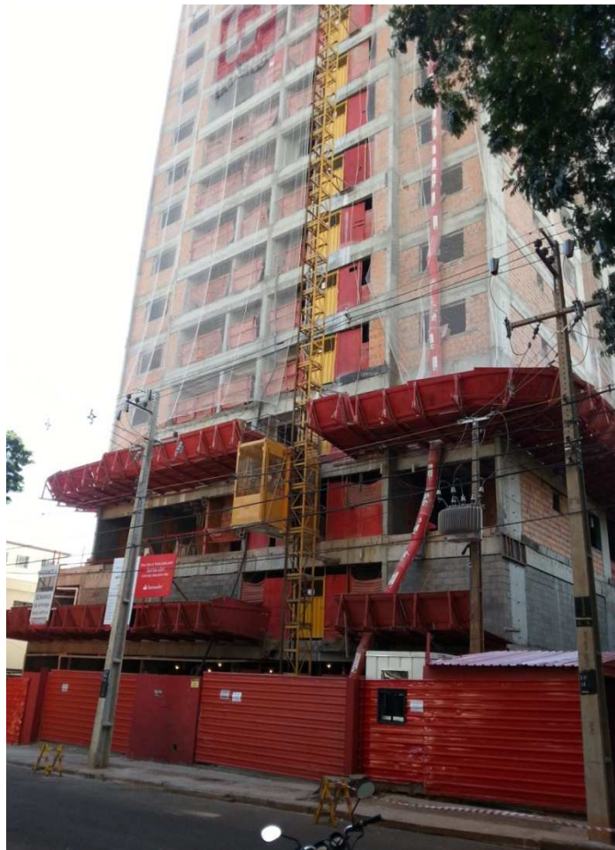
Figura 19-Fachada Edifício 02 em construção Fonte: Autor
