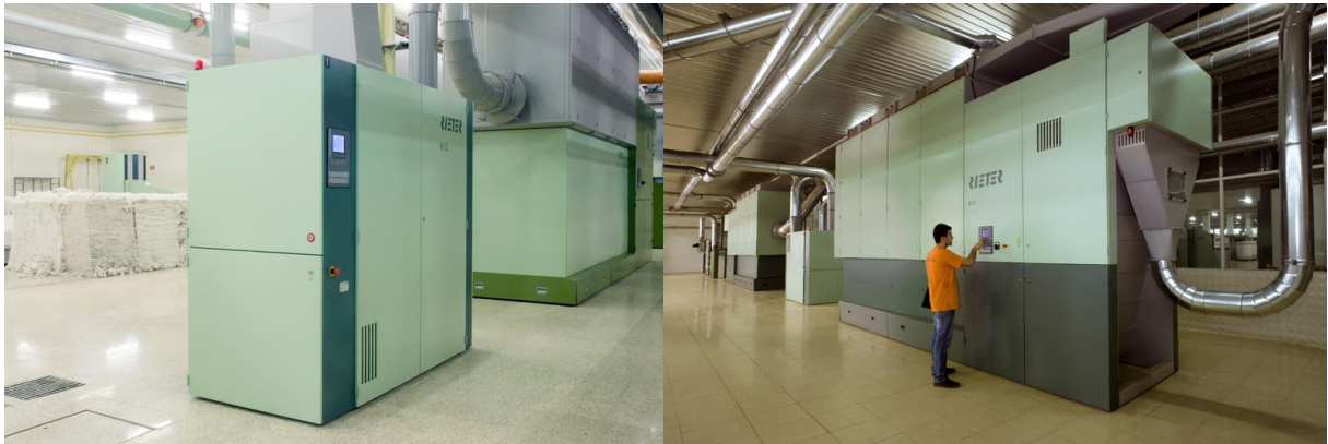
Figura 6: Batedor, misturador, limpador e condensador. Fonte: Rieter (2014)
