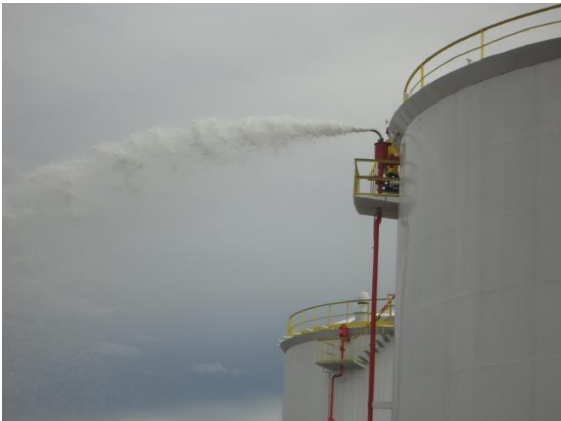
Figura 8: Canhão de LGE em ação demonstrativa.
