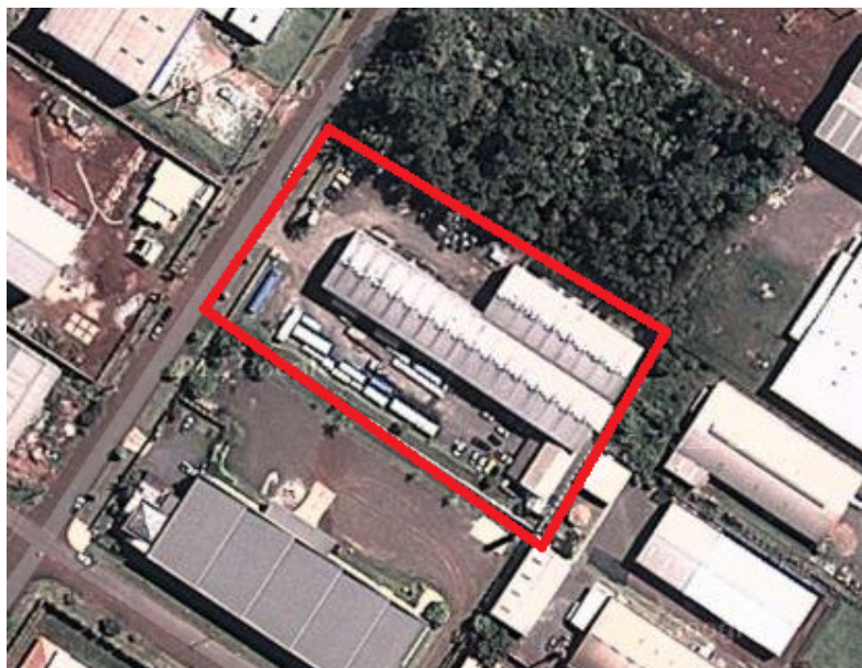
Figura 3: Instalações da empresa XY Fonte: Google Maps
