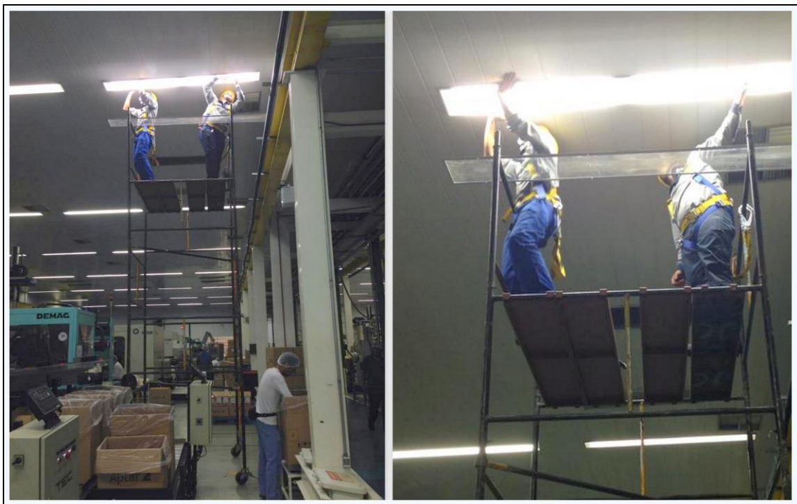
Figura 7 – Colaboradores realizando uma manutenção de luminária.
