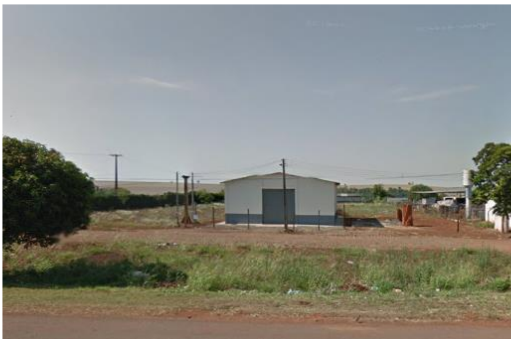
Figura 15: Fachada Frontal Futuras Instalações I
