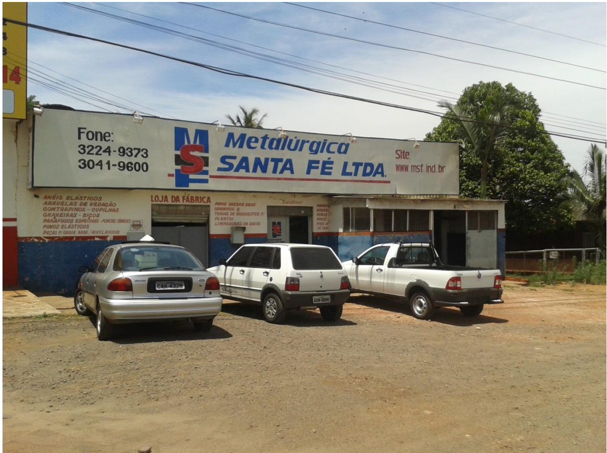
Figura 5: Fachada Metalúrgica Santa Fé - MSF
