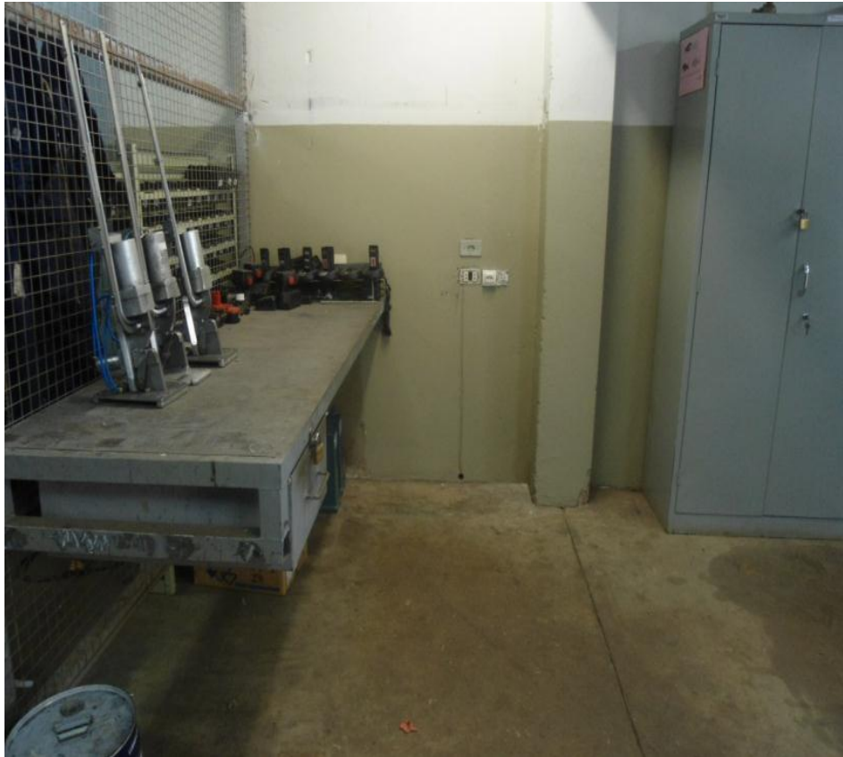
Figura 12 - Sala de Máquinas após dia D
