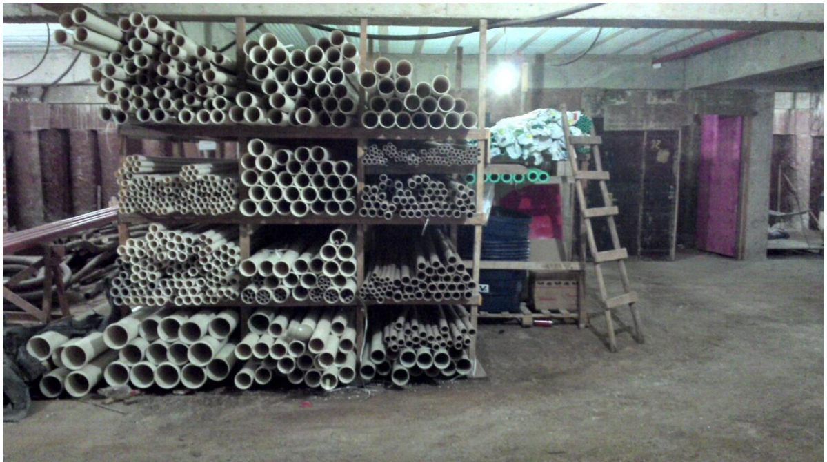
Figura 39: Organização dos Canos do Sistema Hidráulico.
