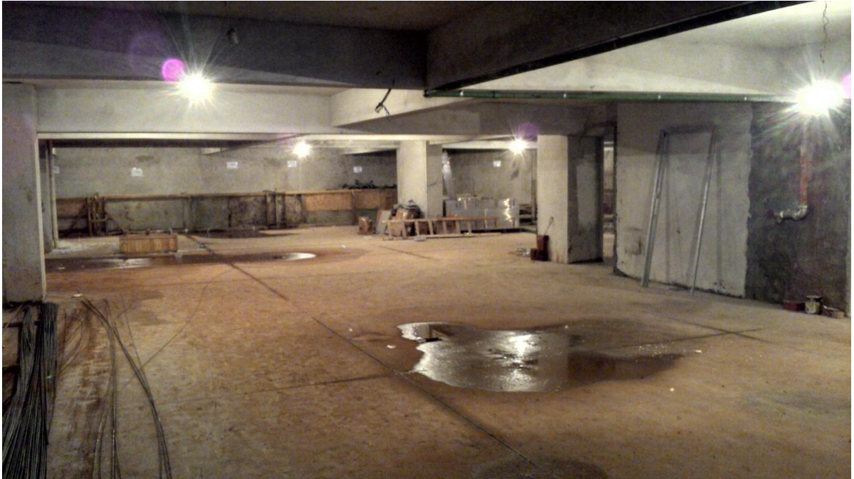
Figura 34: Limpeza geral da obra.
