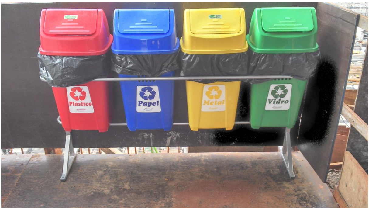
Figura 37: Separação dos Resíduos Gerados em Obra.
