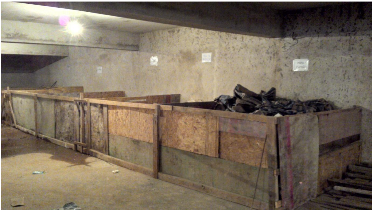
Figura 35: Separação dos Resíduos Gerados em Obra.
