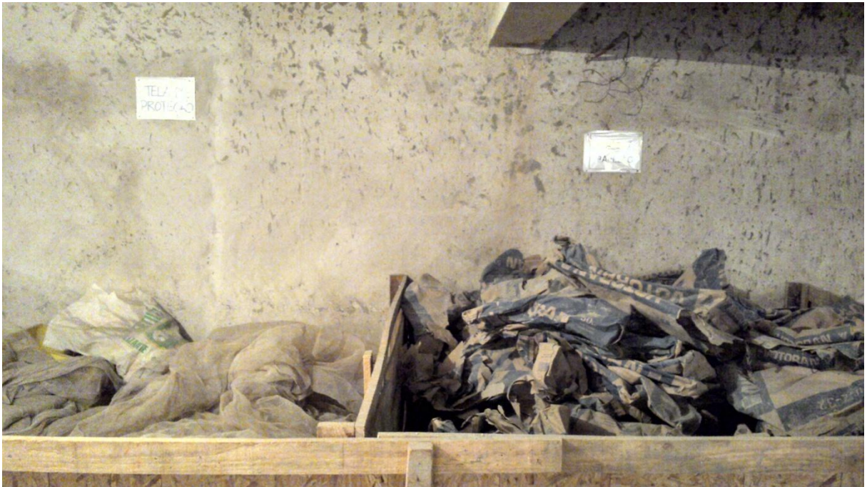
Figura 36: Separação dos Resíduos Gerados em Obra.
