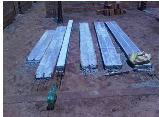
Figura 24: Fabricação das vergas de janelas
