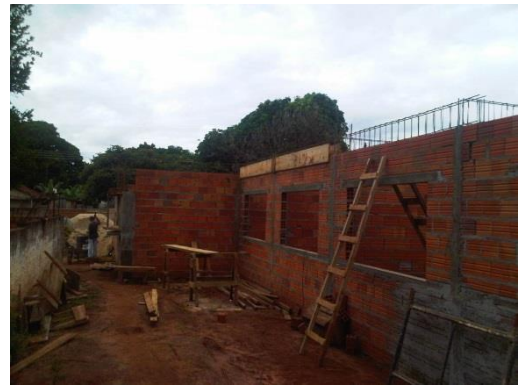
Figura 21: Alvenaria de vedação e montagem das formas e armaduras dos pilares e viga de respaldo
