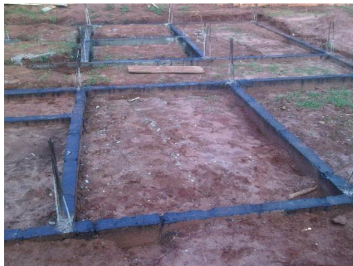
Figura 16: Viga baldrame impermeabilizada
