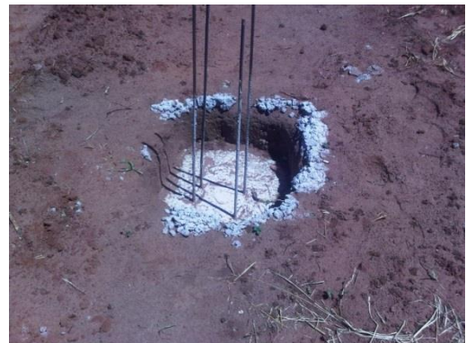
Figura 13: Estaca escavada concretada
