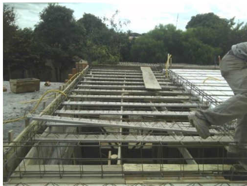
Figura 28: Montagem da laje de vigotas pré-moldada em concreto armado
