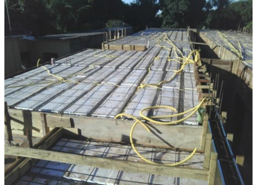
Figura 27: Laje de vigotas pré-moldada em concreto armado
