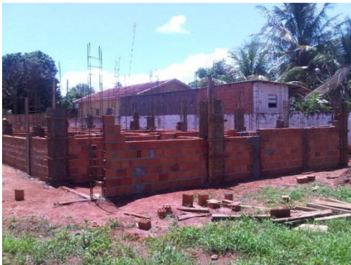
Figura 17: Alvenaria de vedação e montagem das formas e armaduras dos pilares
