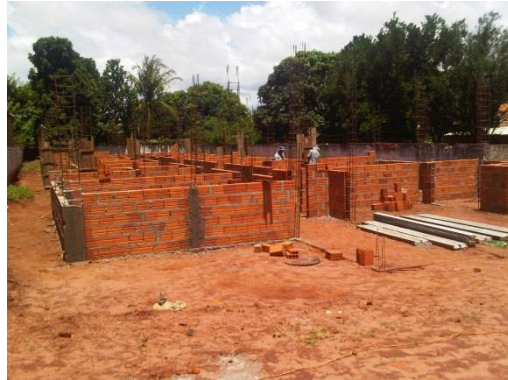
Figura 19: Alvenaria de e montagem das formas e armaduras dos pilares
