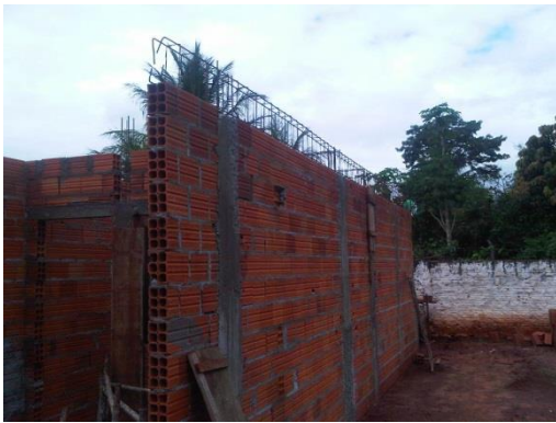
Figura 20: Alvenaria de vedação e montagem das formas e armaduras dos pilares e viga de respaldo
