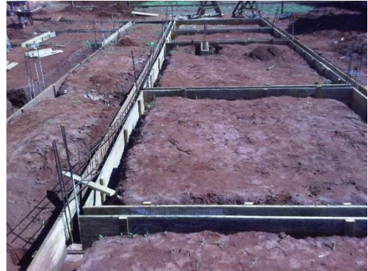
Figura 15: Montagem das formas e armaduras da viga baldrame
