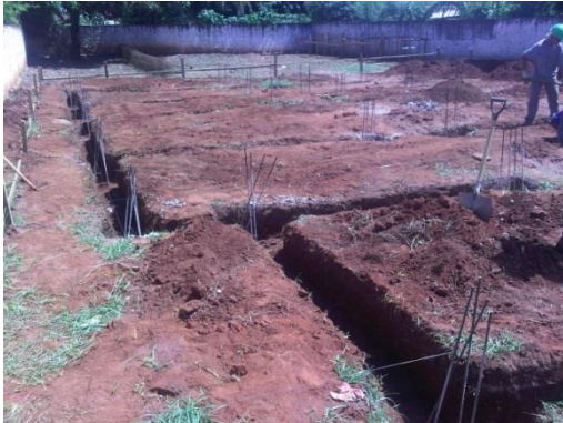
Figura 14: Escavação da Viga baldrame
