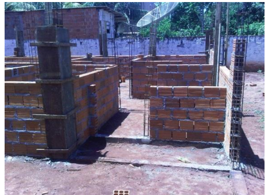
Figura 18: Alvenaria de vedação e montagem das formas e armaduras dos pilares
