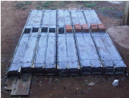
Figura 23: Fabricação das vergas de portas
