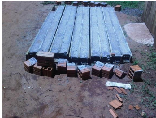
Figura 25: Fabricação das contra-vergas
