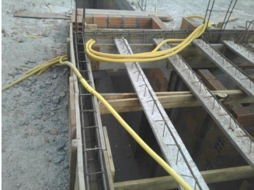
Figura 26: Montagem da laje de vigotas pré-moldada em concreto armado
