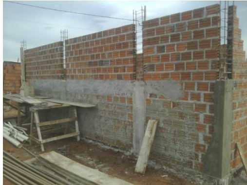
Figura 22: Alvenaria de vedação e montagem
