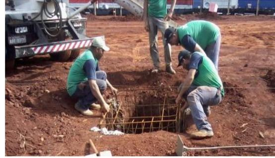
Figura-15: Montagem de bloco
