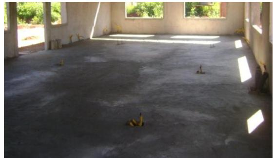
Figura-26: Caixas elétrica no piso
