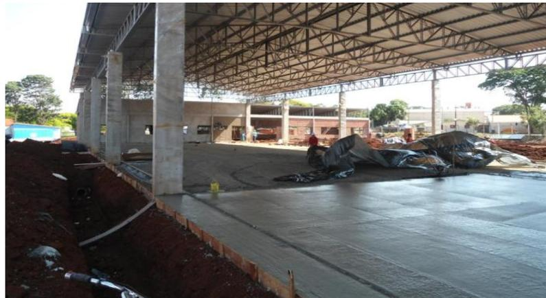
Figura-24: Detalhe da rede de águas pluviais e piso.
