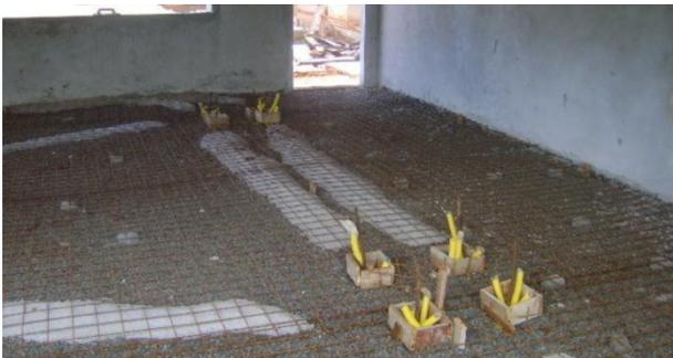
Figura-25: Detalhe da tubulação Elétrica
