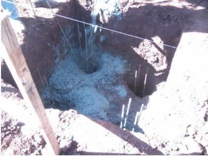
Figura-14: Estacas do bloco
