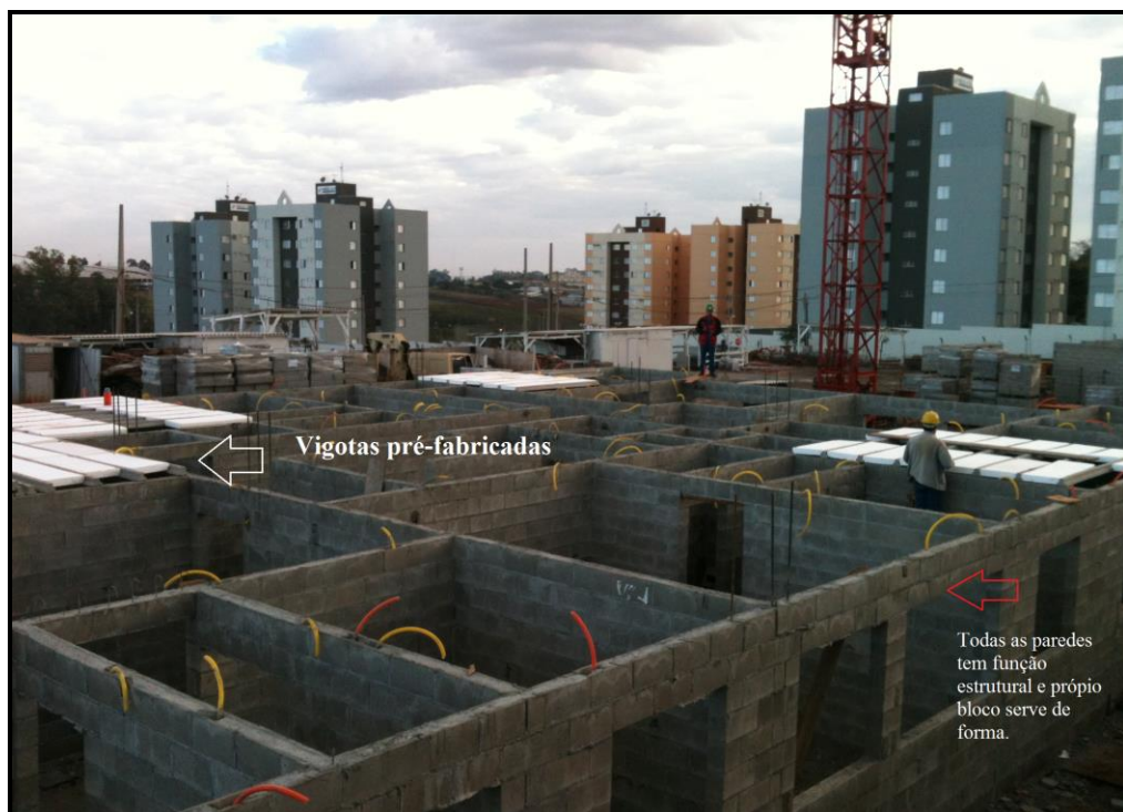
Figura 12 – Edificação executada em alvenaria estrutural
