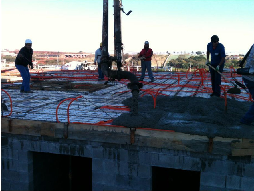
Figura 14 – Concretagem de laje com bombeamento mecânico do concreto Fonte: o Autor
