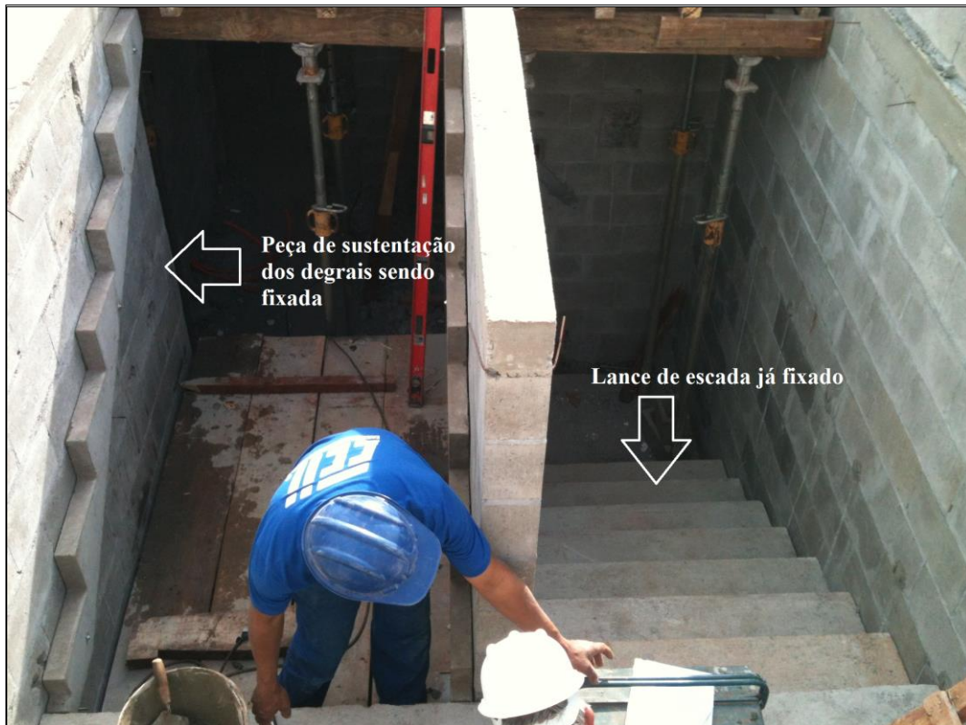
Figura 13 – Montagem da escada tipo jacaré Fonte: o Autor
