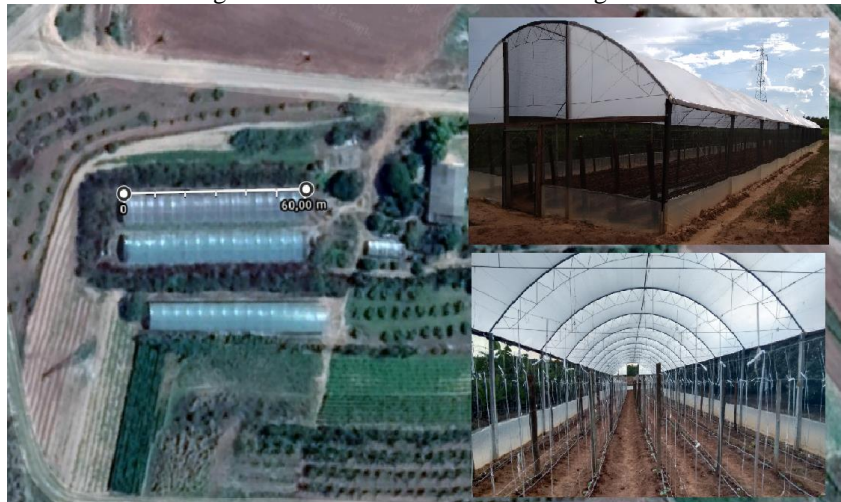
Figura 5: Local e estrutura da estufa agrícola
