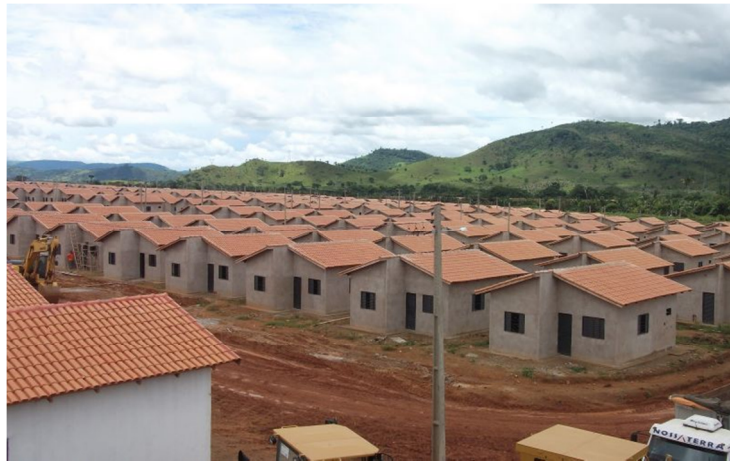
Figura 11 – Obra da cidade de Maringá-PR
