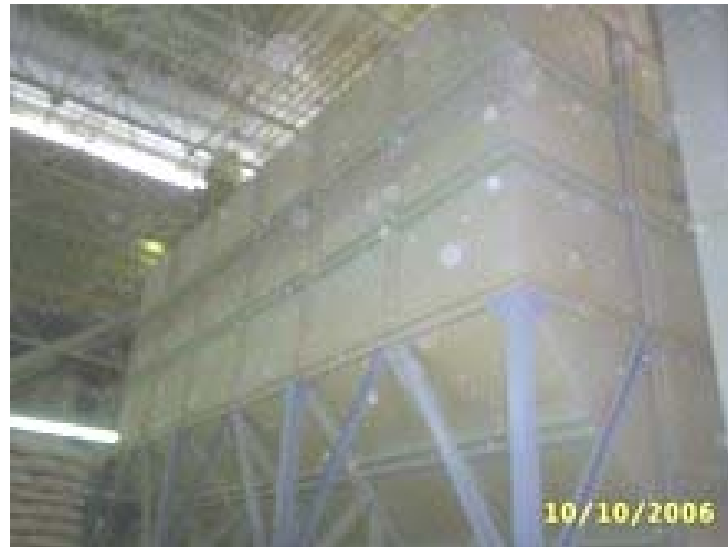
Figura 10- Silos de Canjica
