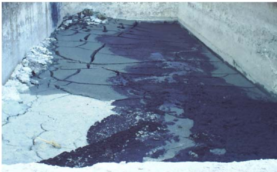
Figura 18 – Leito de secagem Fonte: Primária
