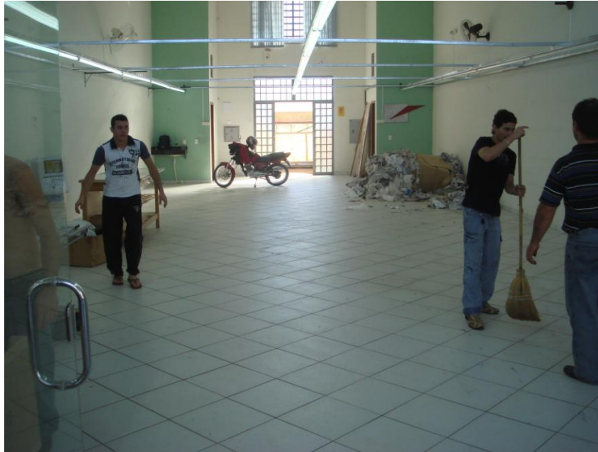
Figura 12: Salão sendo preparado para receber as máquinas.
