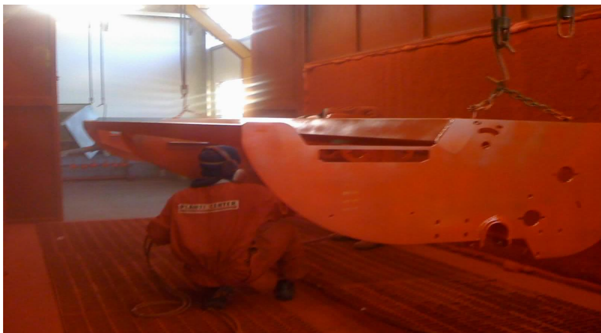
Figura 23: Pintura da última camada de tinta.
