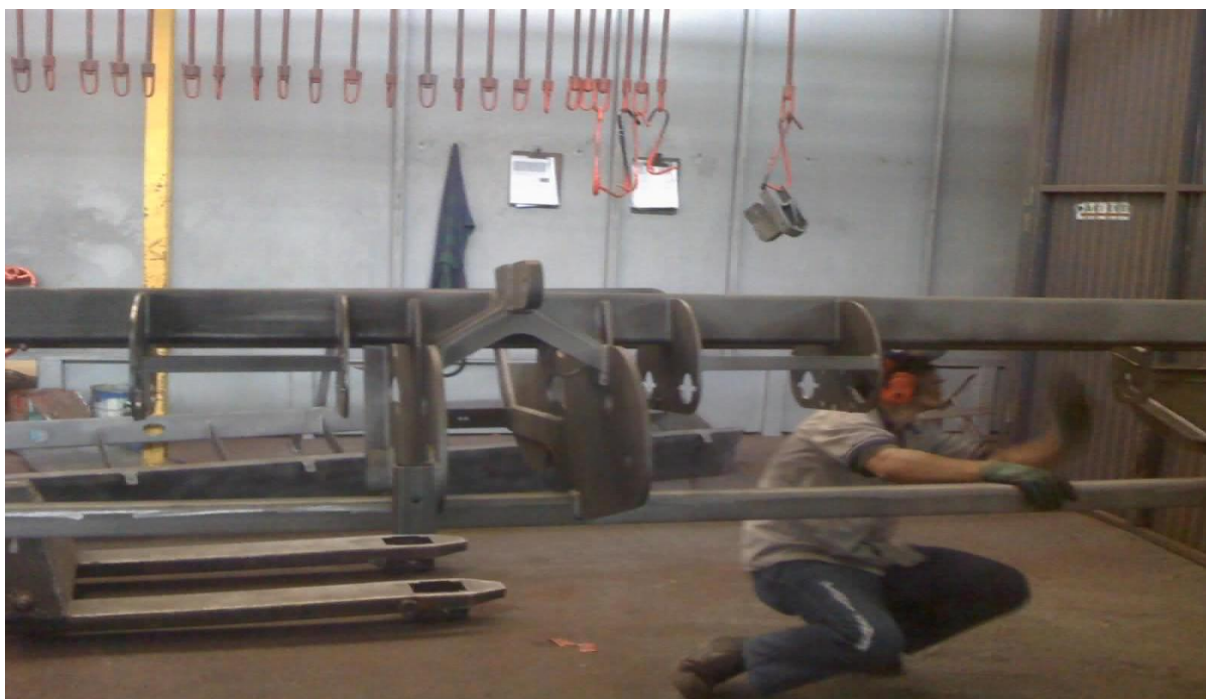
Figura 13: Inspeção do jateamento.
