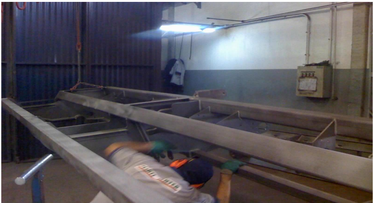
Figura 12: Inspeção da solda.
