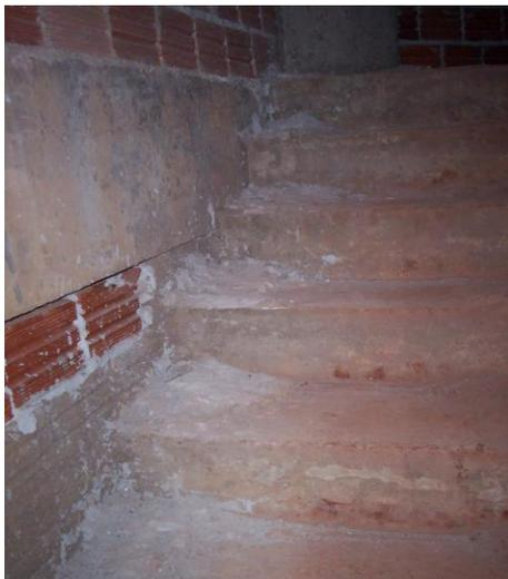
**Figura 4.10:** Perda de argamassa na execução da alvenaria.
