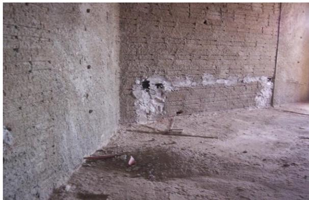
**Figura 4.12: Parede chapiscada com método convencional e desperdício em um cômodo**
