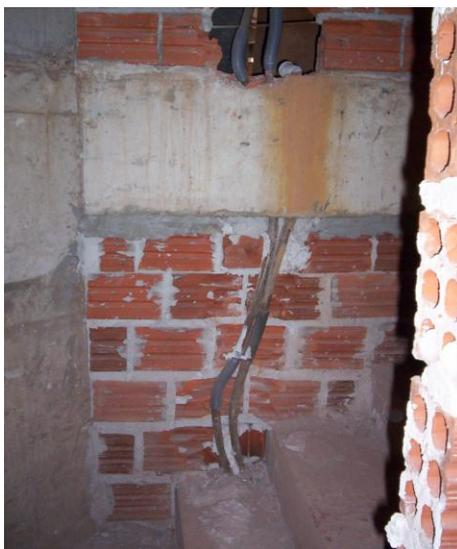
**Figura 4.11:** Passagem de tubulações elétricas na alvenaria e na viga.
