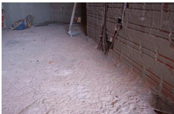
**Figura 4.14: Limpeza na obra quando utilizado o chapisco rolado.**
