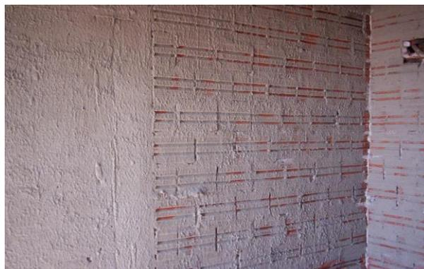
**Figura 4.13: Parede chapiscada com rolo**
