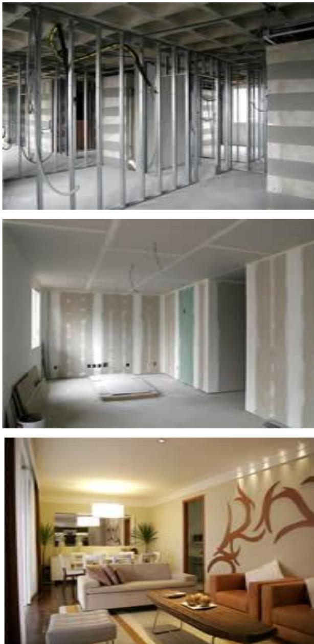
**Figura 2.3: Montagem de uma parede em drywall.”**
