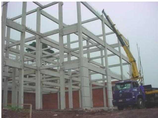
**Figura 2.4: Estrutura em concreto pré-fabricado. Fonte: [www.iacc.com.br](http://www.iacc.com.br).**
