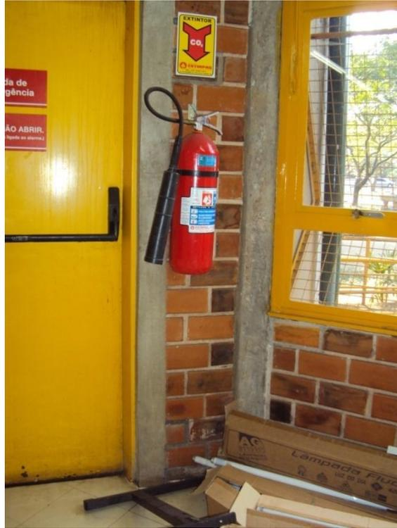
**Figura 12: Extintor obstruído por lâmpadas fluorescentes**
