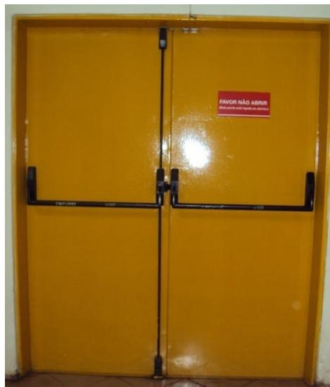
Figura 8: Saída de Emergência com largura de 1,70m (um metro e setenta centímetros)
