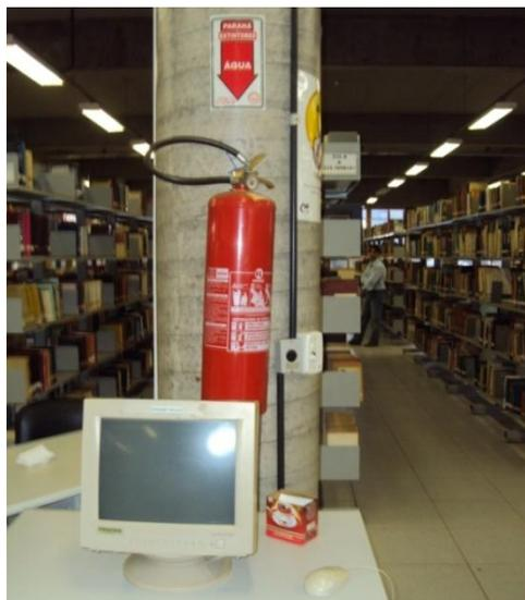
**Figura 10: Extintor de água próximo de equipamento eletrônico**
