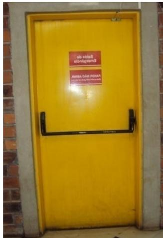
Figura 7: Saída de Emergência com largura de 1,20m (um metro e vinte centímetros)
