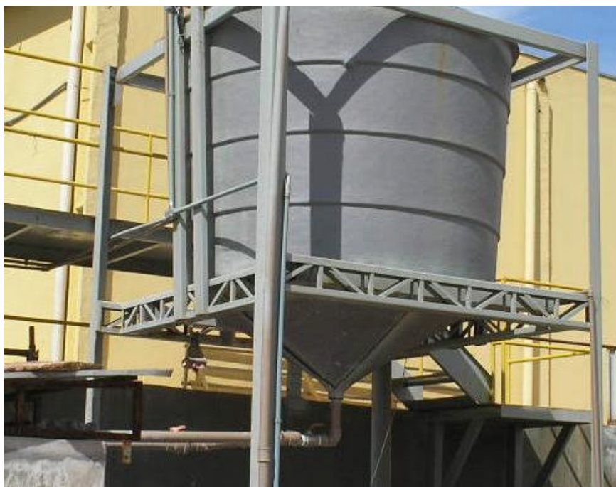
Figura 04: Decantador
