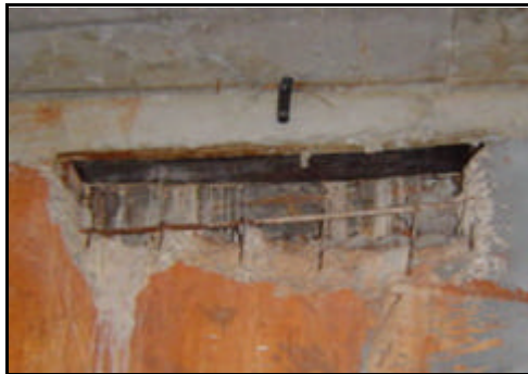
Figura 13 - Nicho de concretagem. Fonte: Carla F. Marek, (2005).
