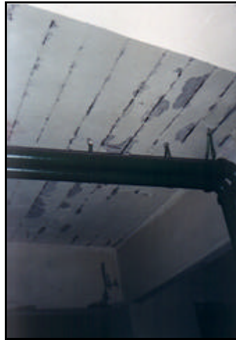
Figura 15 - Lascamento do concreto Fonte: Jefferson Maia Lima, (2000).
