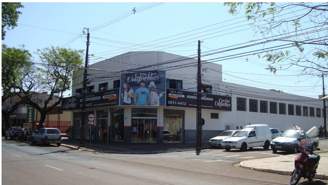
Figura 6 – Fachada da empresa
