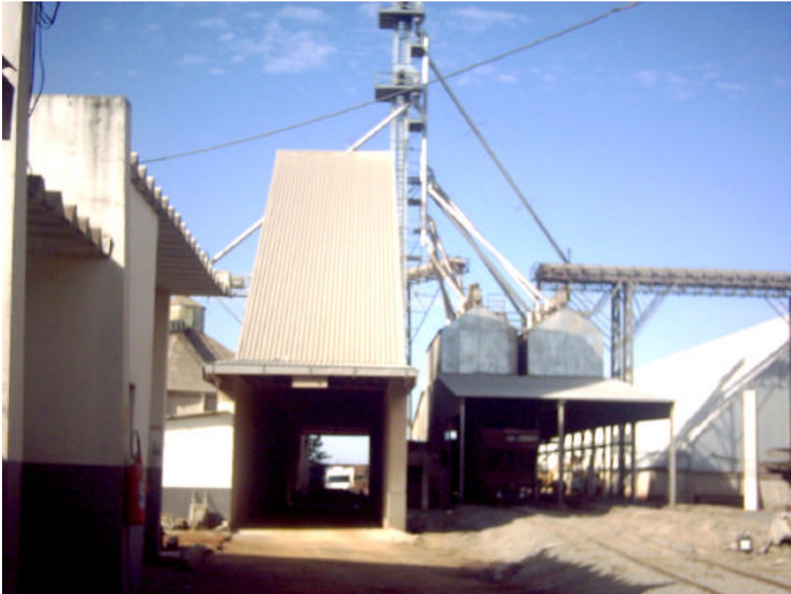
Figura 8: Vista de trás da plataforma de descarga.
