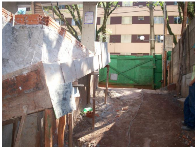
Figura 3: Detalhe da calha.
