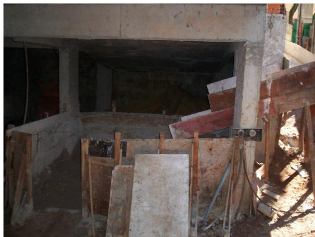
Figura 4: Caixaria de Argamassa
