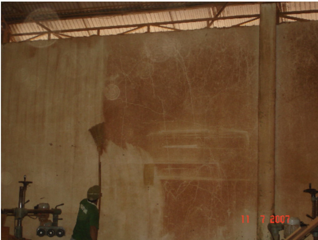
Figura 3: Limpeza das paredes da fábrica
