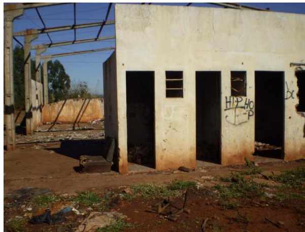
Figura 11: prédio administrativo do aterro atualmente
