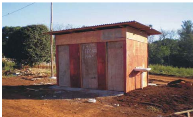
Figura 02: Instalação provisória no canteiro de obras. Fonte: Arquivo pessoal.
