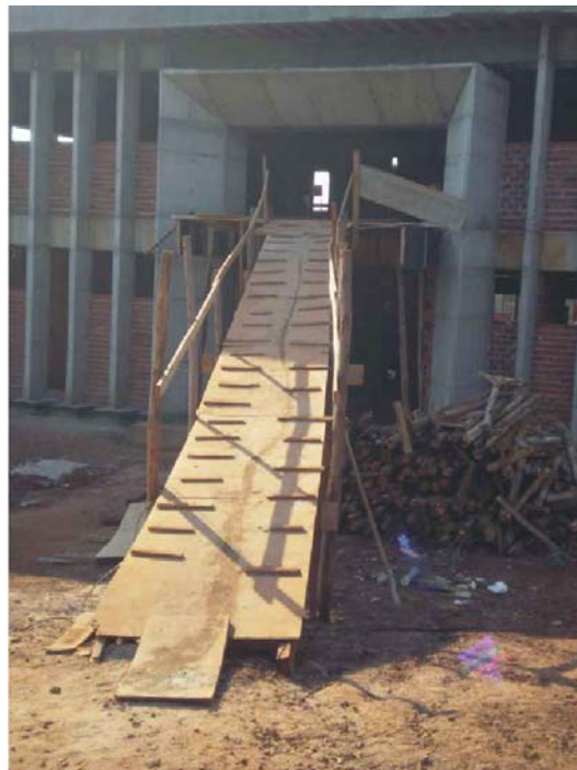
Figura 08: Rampa de acesso de materiais e funcionários Fonte: Arquivo pessoal
