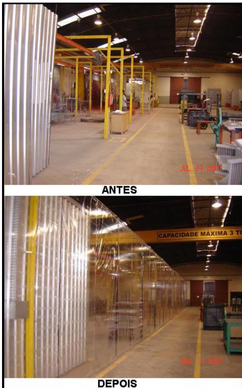
Figura 26: Situação anterior e atual da área de pintura.
