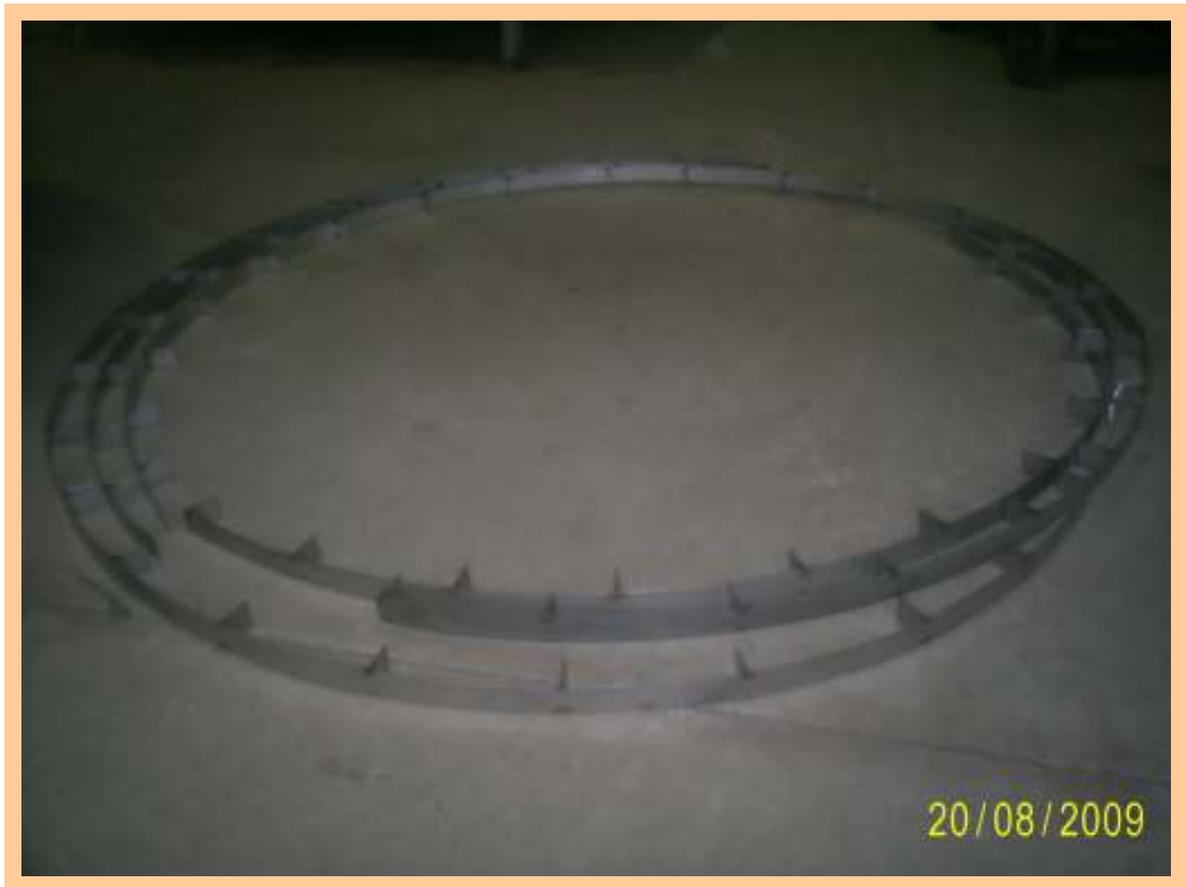
**Figura 48 - Preparação dos anéis para fixação da lã de rocha.**
