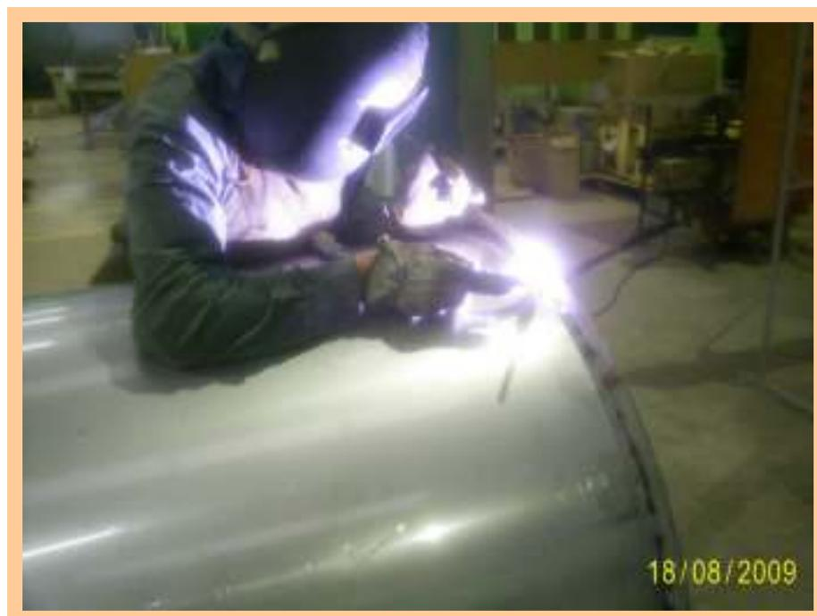
**Figura 26 - Solda do Anel superior no corpo externo.**
