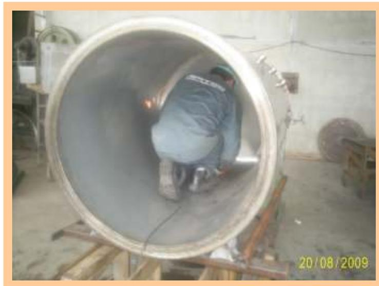
**Figura 36 - Polimento da solda interno do fundo.**
