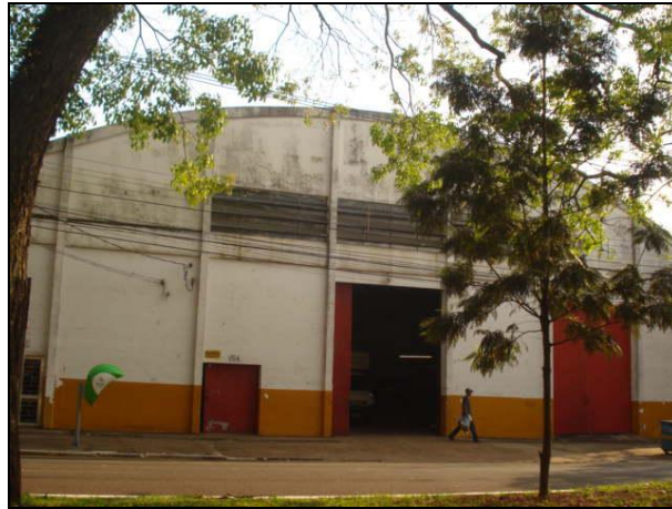
Figura 2 – Fachada do Barracão 1
