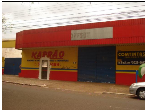
Figura 15 – Fachada do barracão 2
